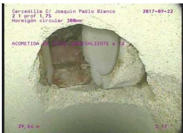
, 00:03:04, 29.64 ACOMETIDA EN TECHO SOBRESALIENTE a 12
