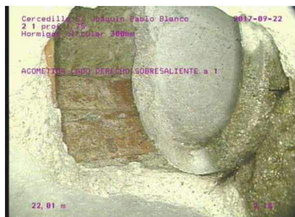
, 00:02:19, 22.01 ACOMETIDA LADO DERECHO SOBRESALIENTE a 1
