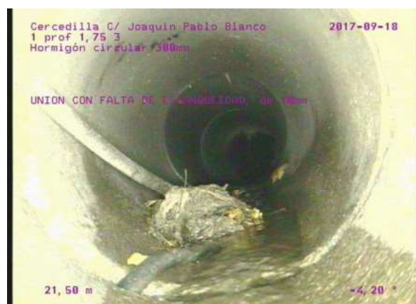
, 00:02:56, 21.50 UNION CON FALTA DE ESTANQUEIDAD, de 10mm
