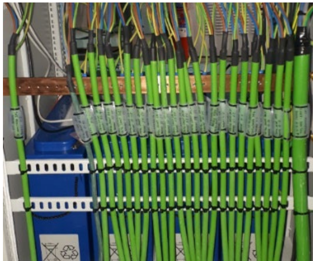
EJEMPLO DE ENTRADA DE MANGUERAS AL ARMARIO.
