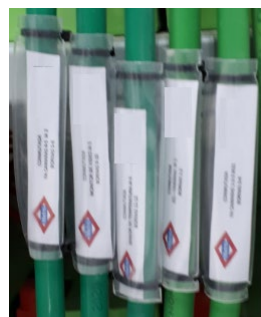
Ejemplo de etiquetado con placa señalizadora
