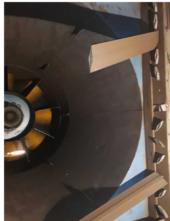
Foto 13: Ventilador con compuertas rotas.
