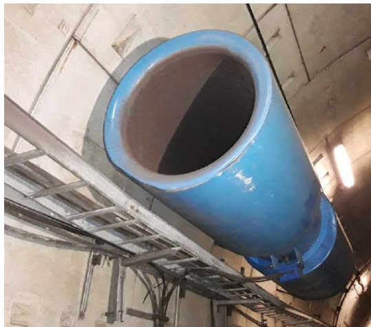
Foto 7: Ventilador Jet.
