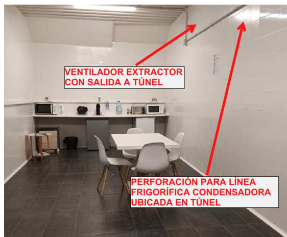
Ilustración 8-9. Instalaciones de climatización y ventilación. Estado reformado. Estación de Pinar de Chamartín
