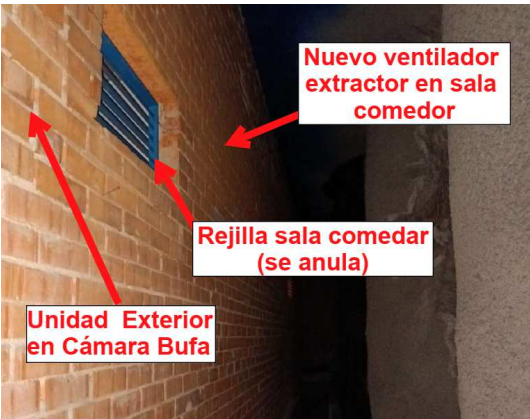
Ilustración 8-18. Cámara bufa. Actuaciones estado reformado. Estación de Nuevos Ministerios.
