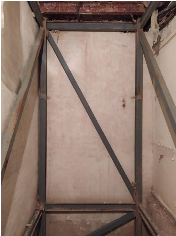
Estructura de ascensor en espacio interior que se mantiene, con su correspondiente limpieza, reparación de soldaduras e imprimación de los perfiles.
