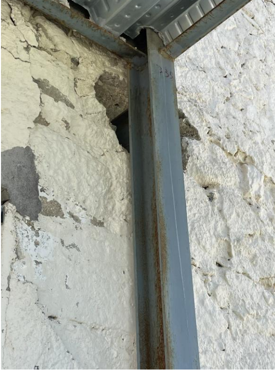
Encuentro a retacar de estructura metálica con el muro existente de cerramiento del edificio principal.
