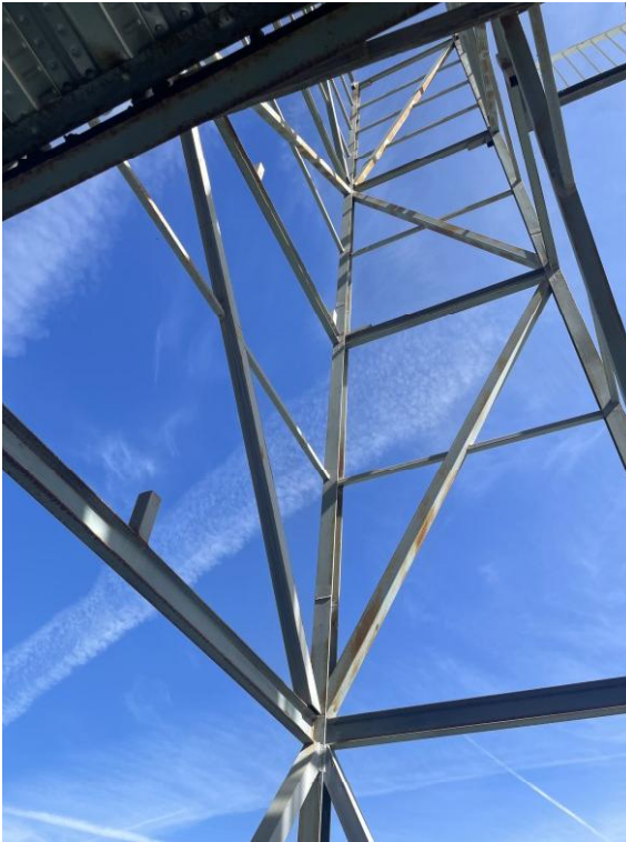
Estructura del ascensor en espacio exterior que se mantiene, con su correspondiente limpieza, reparación de soldaduras e imprimación de los perfiles.
