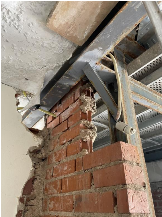
Encuentro a retacar de estructura existente - forjado- con estructura metálica nueva.
