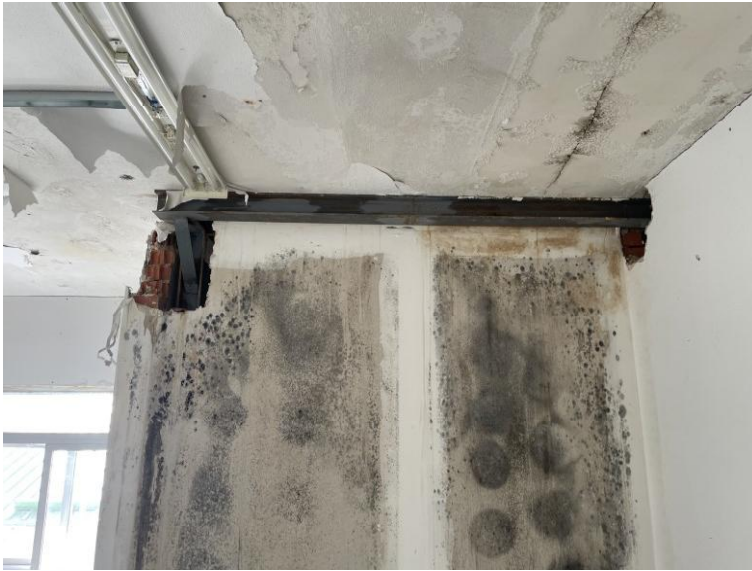
Estado de estancia junto al espacio del ascensor dañado por las humedades.
