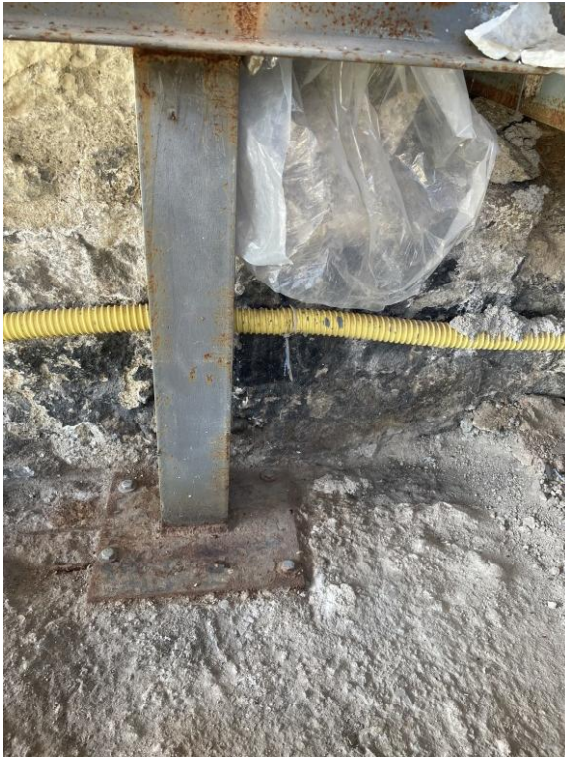
Placa de anclaje de pilar del ascensor a forjado de cubierta.
