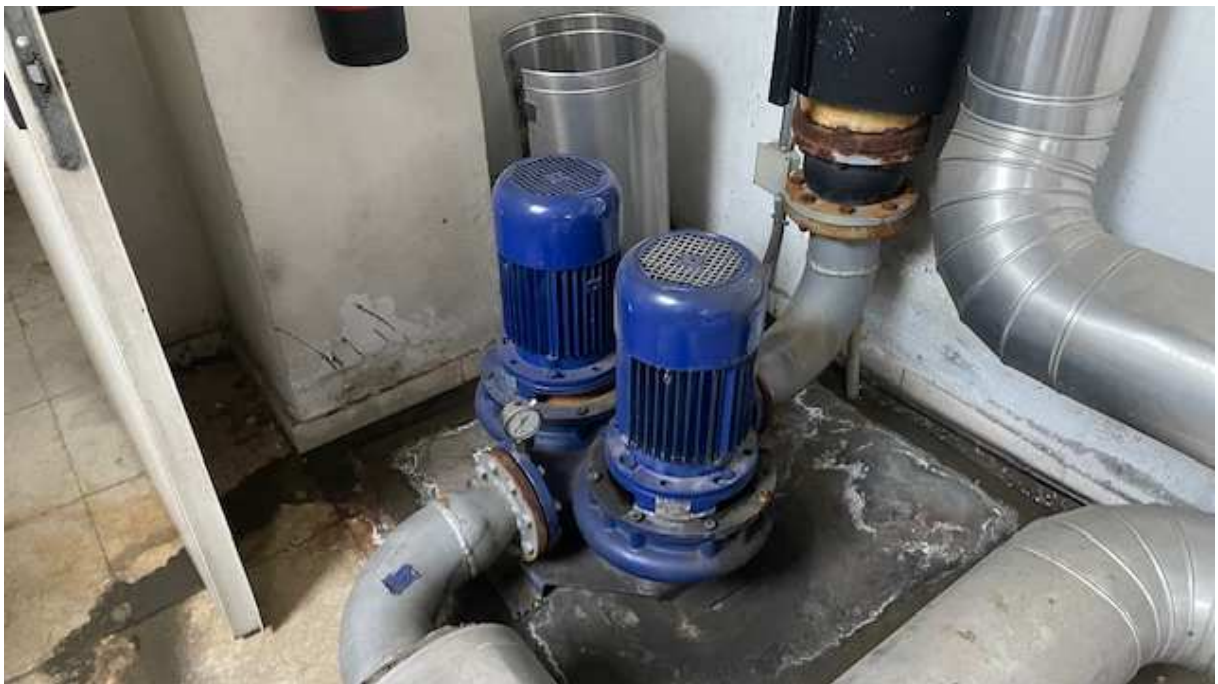
Foto 3 Bomba de recirculación frío
