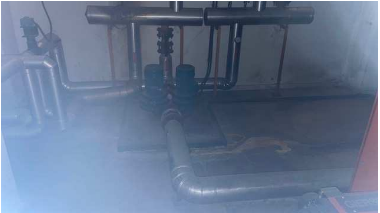
Foto 4 bomba de recirculación calor
