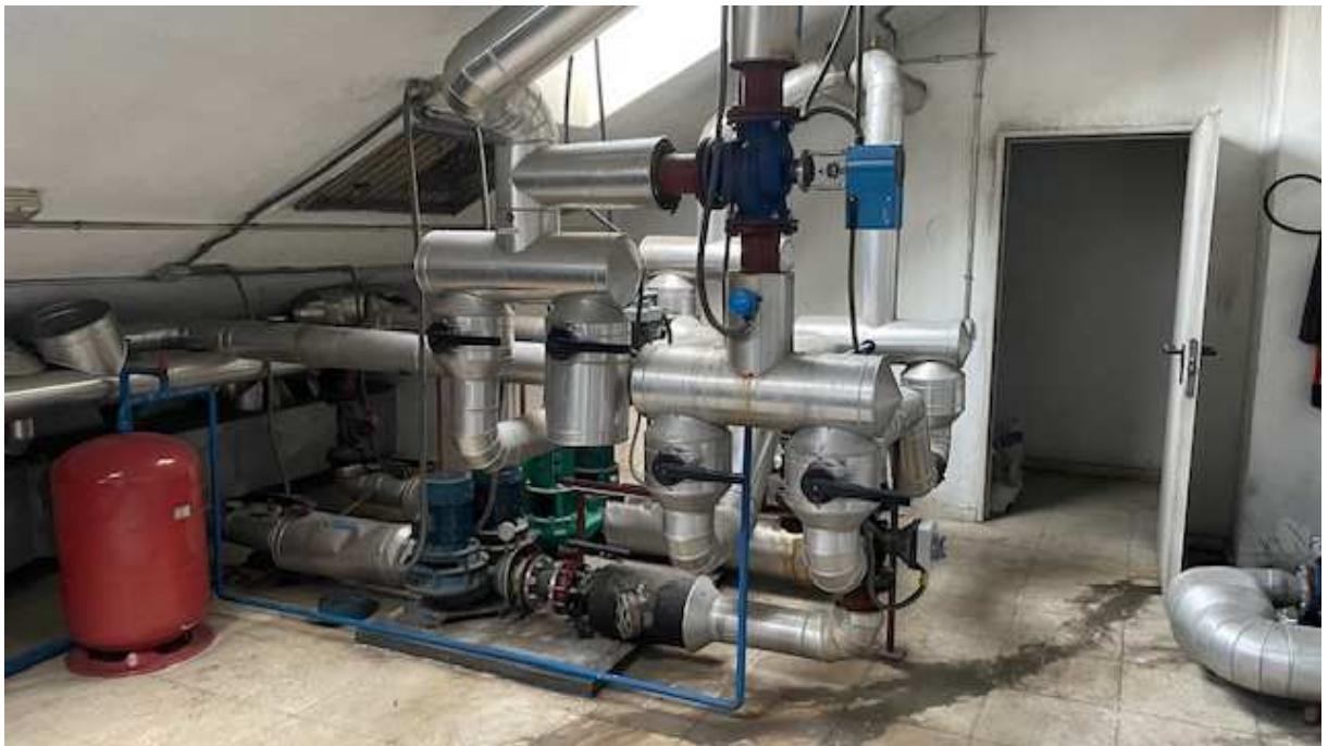
Foto 8 Circuitos de fancoils
