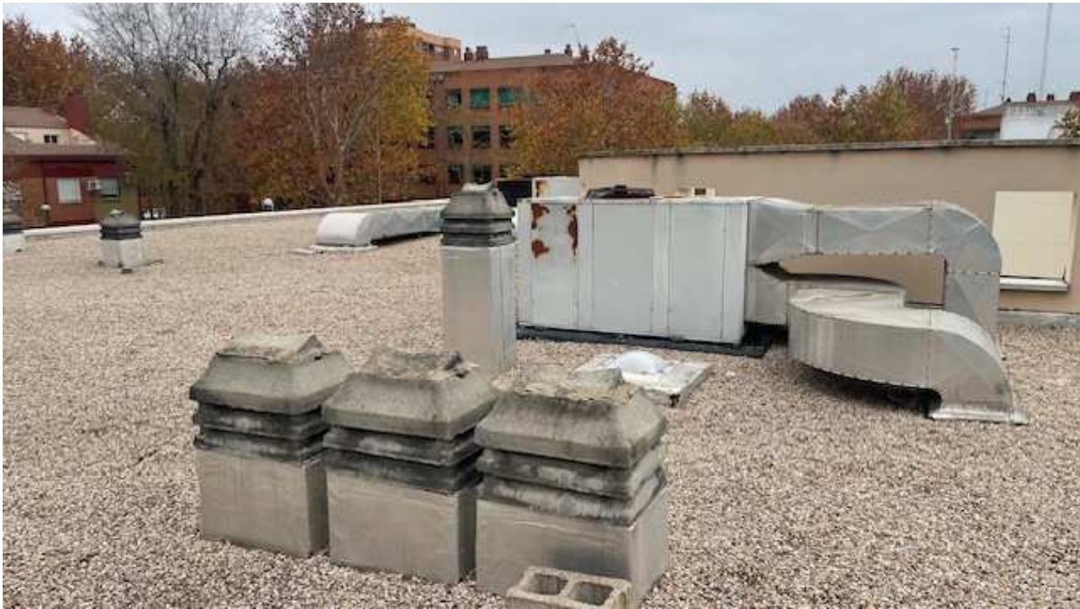
Foto 2 Bomba de calor 2 CIATESA IPC 315
