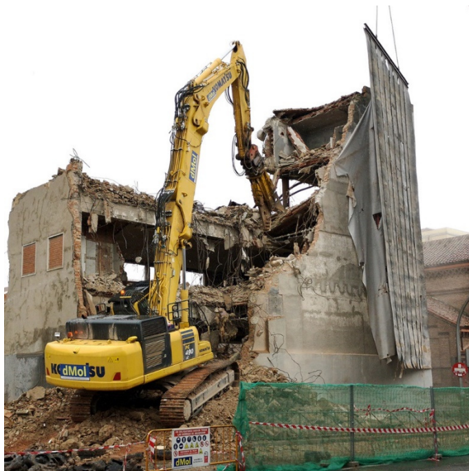
foto_01. Retroexcavadora con demoledor primario de rotación continua de 360°
