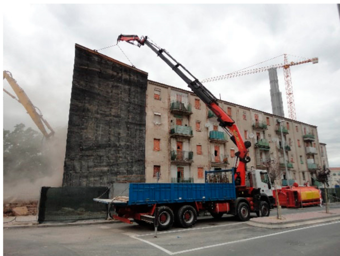
foto_02. Pantalla de protección suspendida por grúa autopropulsada
