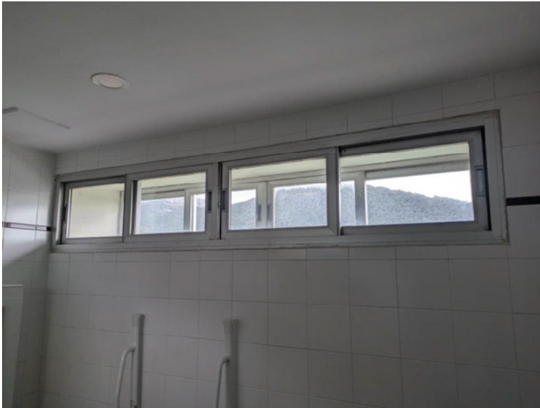
Ventanas de los cuartos de baño de las habitaciones del ala norte situadas en los extremos del HOS3 donde se sustituye la carpintería interior y el vidrio.
