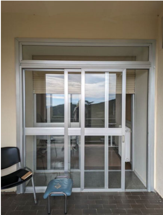
Ventanales de salida a terraza desde las habitaciones del ala sur del HOS3 donde se derriba la carpintería interior, sustituye la carpintería exterior y el vidrio y se instalan persianas.
