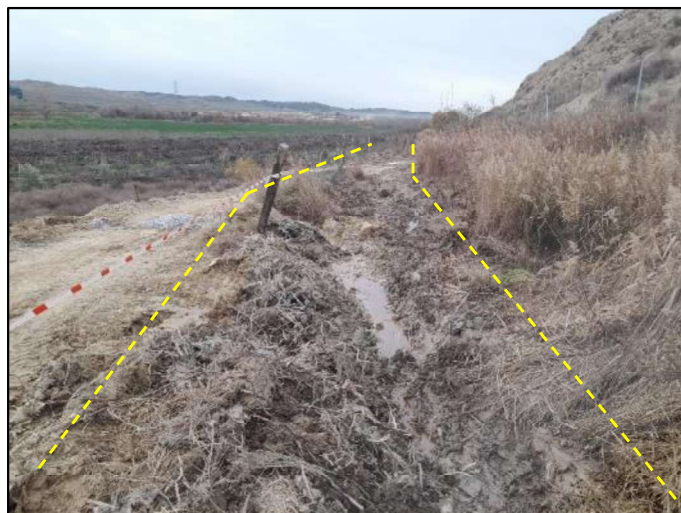
Figura 13. Detalle del camino (entre líneas amarillas) completamente inutilizado
