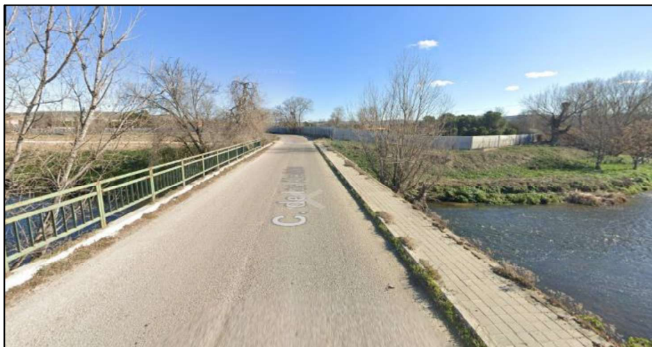
Figura 16. Imagen del tramo en el que falta una barandilla
