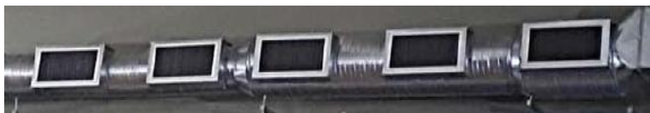
Rejilla de retorno en conducto circular
