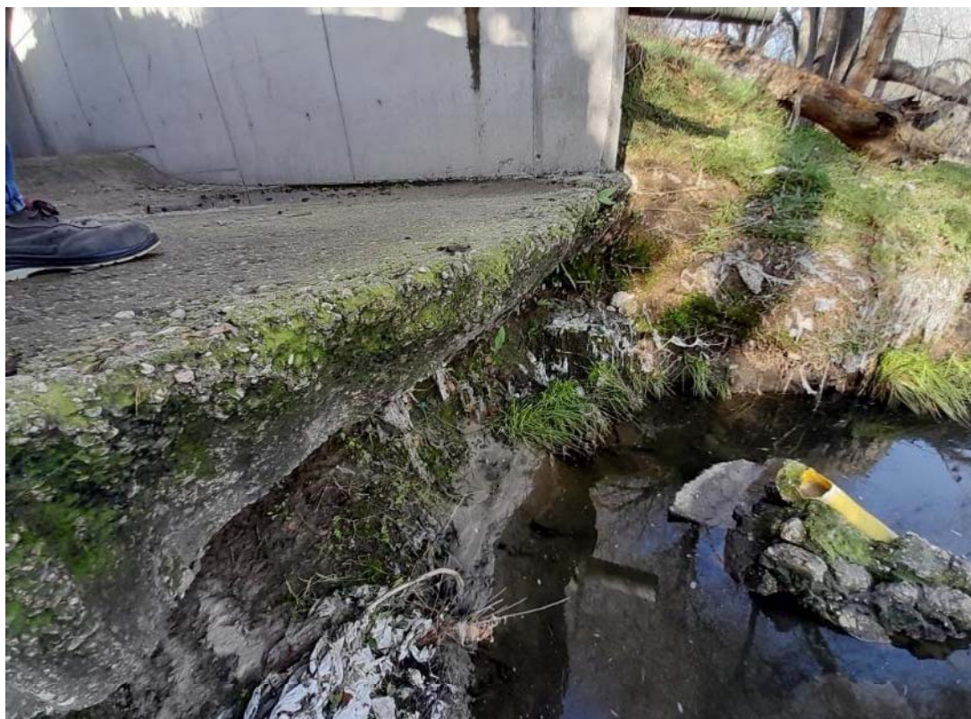
Ilustración 5 - Zona obra civil afectada en Colector Butarque II.
