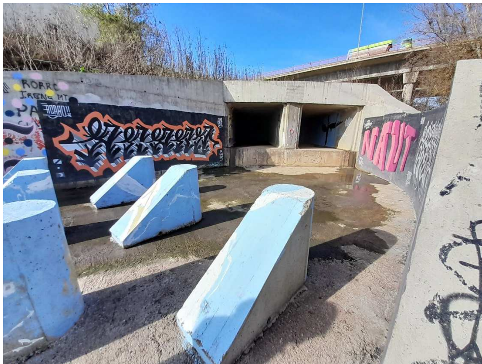
Ilustración 4 – Detalle obra de alivio a cauce del by-pass general de la EDAR.
