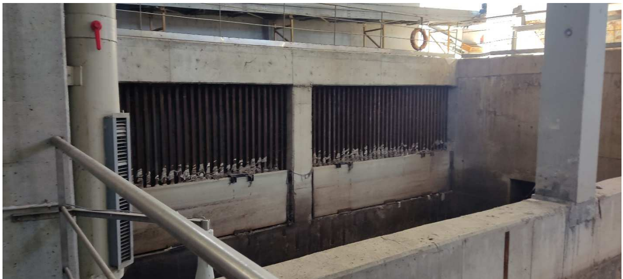
Ilustración 1 – Edificio de pretratamiento. Pozo de gruesos.
