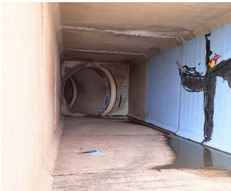
Ilustración 5 – Conducción Ø1800 by-pass general de la EDAR.
