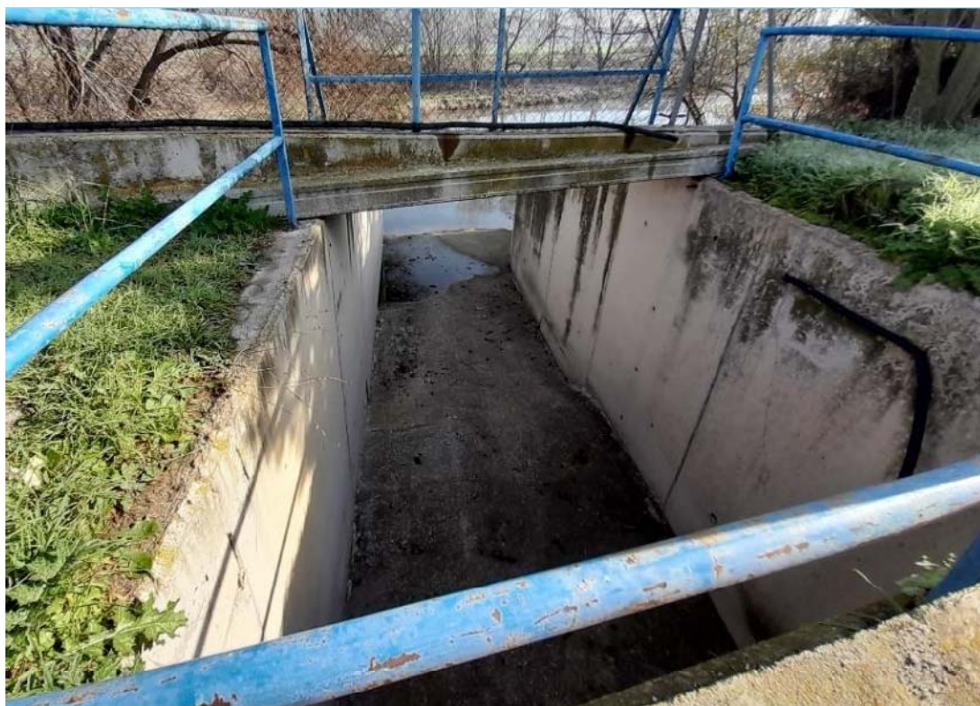
Ilustración 4 - Sección rectangular en canal abierto del colector Butarque II.
