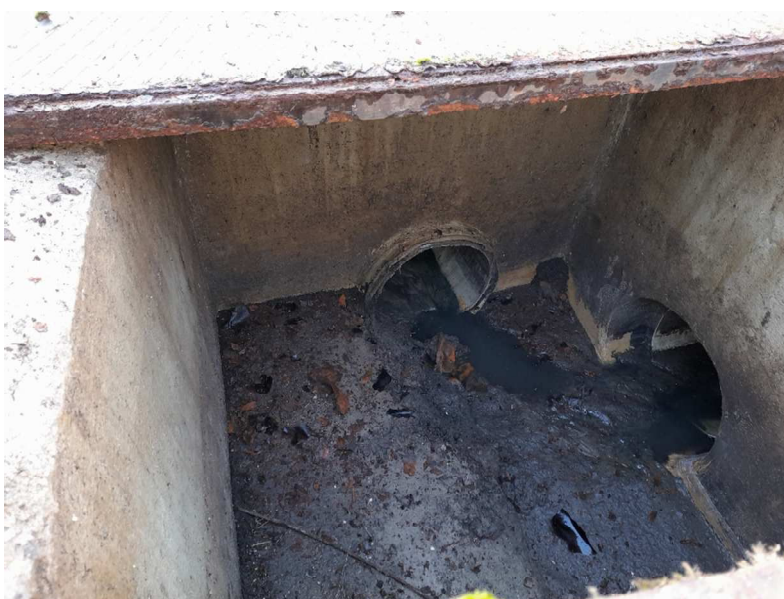
Ilustración 9 – Interior de arqueta con posible afección.
