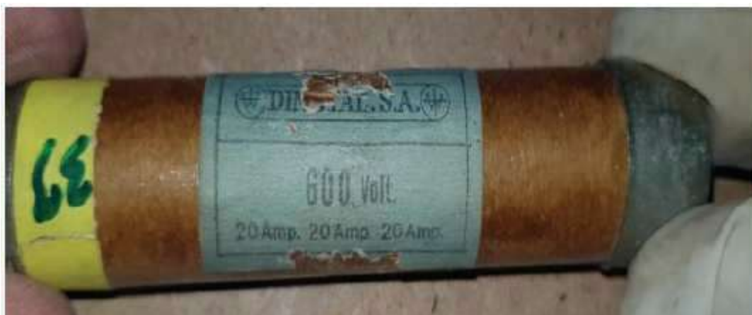
Ilustración 3 Fusibles de alimentación de los circuitos de vía
