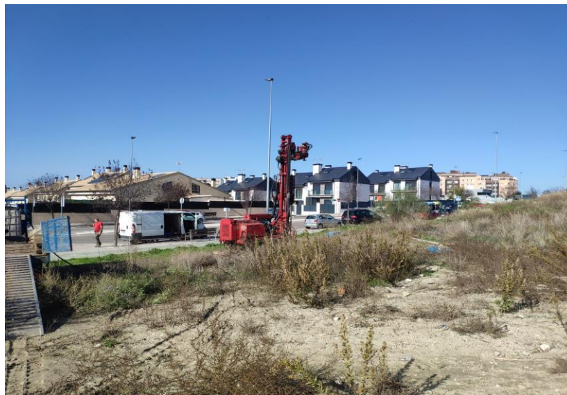
Figura Nº 6.- Imagen de la ejecución del sondeo mecánico y rotativo con extracción continua de testigo referido como S-02.
