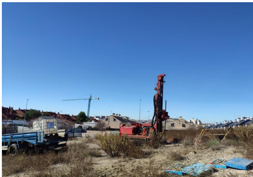
Figura Nº 5.- Imagen de la ejecución del sondeo mecánico y rotativo con extracción continua de testigo referido como S-01.
