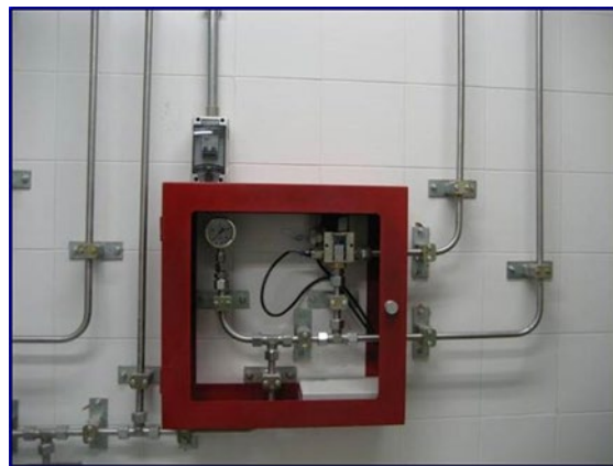
Figura 23 - válvula NS12 extinción cuarto técnico
