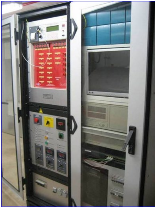
Figura 11 - Panel maestro extinción y cuadro eléctrico bombas
