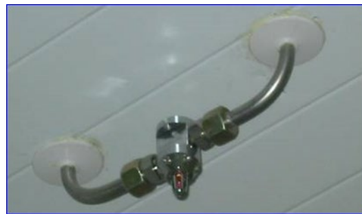
Figura 20 - Boquilla mixta
