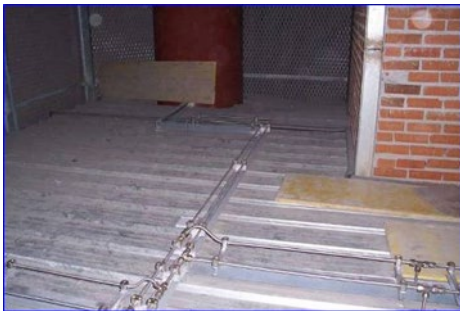
Figura 19 - Tuberías acero inoxidable y soportaciones
