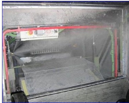
Figura 13 - Extinción en foso escalera mecánica
