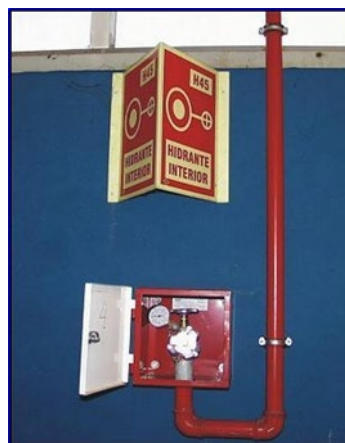
Figura 32 - Hidrante interior
