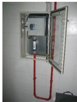
Figura 4– Detector Vesda láser compact
