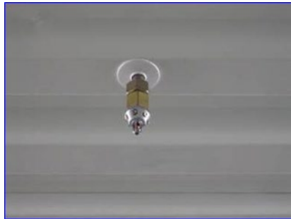
Figura 8 - Boquilla cerrada cuarto no técnico
