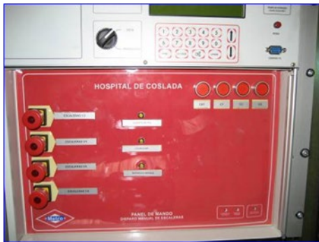
Figura 21 - Panel maestro extinción
