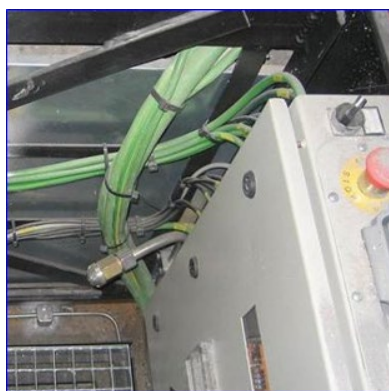
Figura 7 - Boquilla abierta foso escalera mecánica
