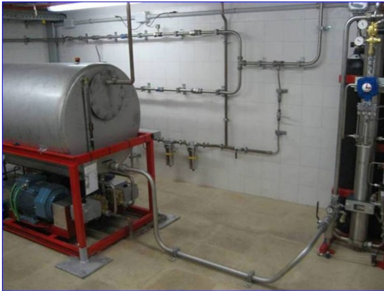
Figura 10 - Cuarto PCI extinción. Cuba almacenaje de agua
