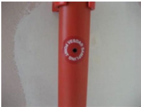
Figura 2– Orificio de aspiración
