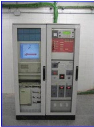
Figura 5 - Cuadros control extinción y equipos integración
