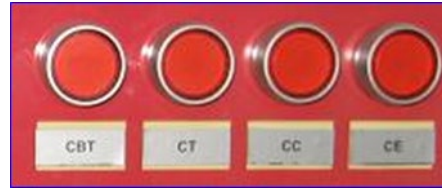
Figura 22 - Pulsadores extinción cuartos técnicos
