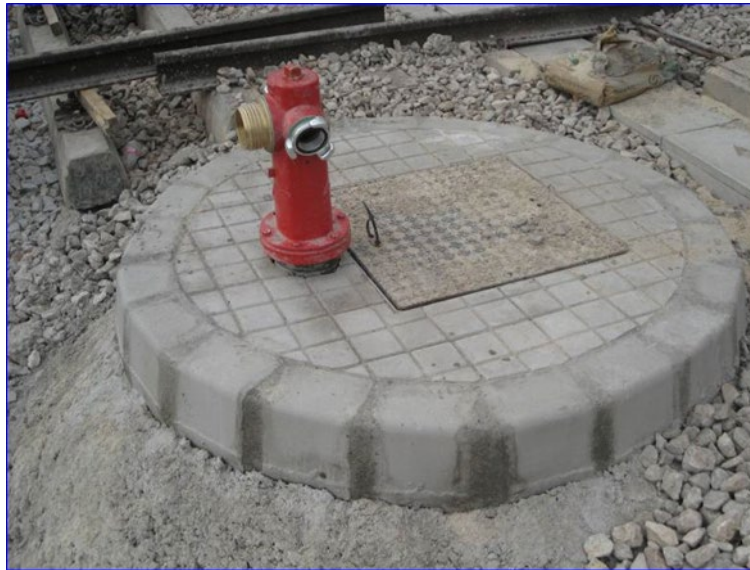
Figura 31 - Hidrante exterior de columna seca
