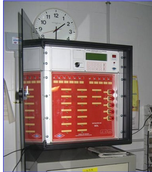
Figura 12 - Panel servidor extinción
