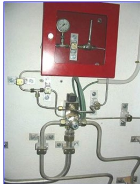
Figura 15 - Válvula extinción NS20 escalera mecánica
