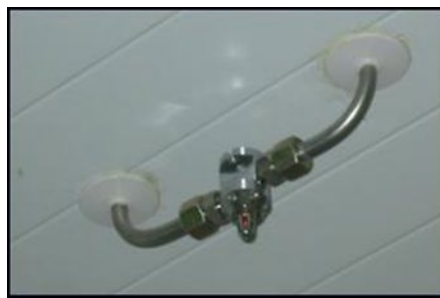
Figura 9 - Boquilla mixta
