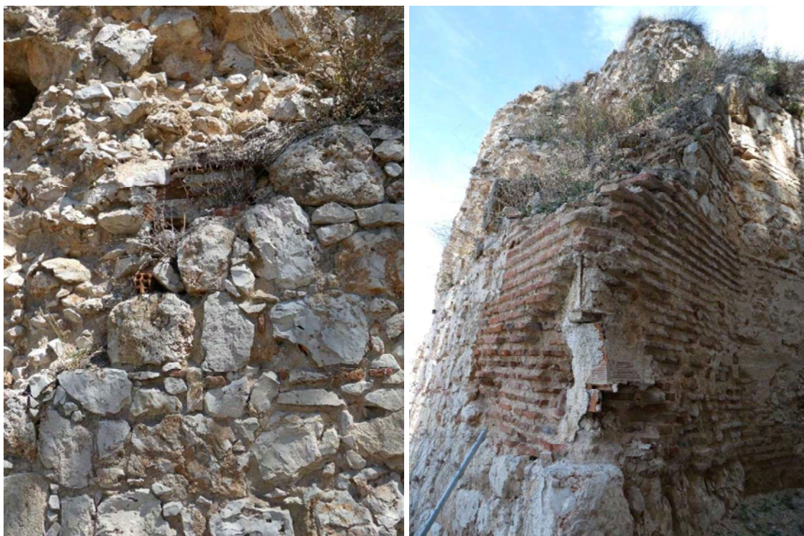
ANT001. Agregado de mortero de cemento. ANT 002. Adosamiento de materiales, resto del antiguo palomar
