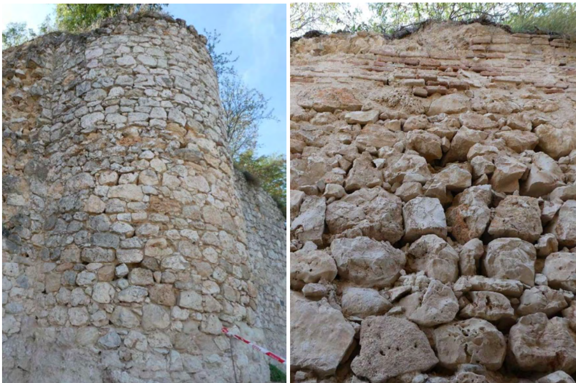
FIS001. Erosión de mortero de cal original en la parte superior del torreón circular y lienzo de muralla en la zona del paso.
