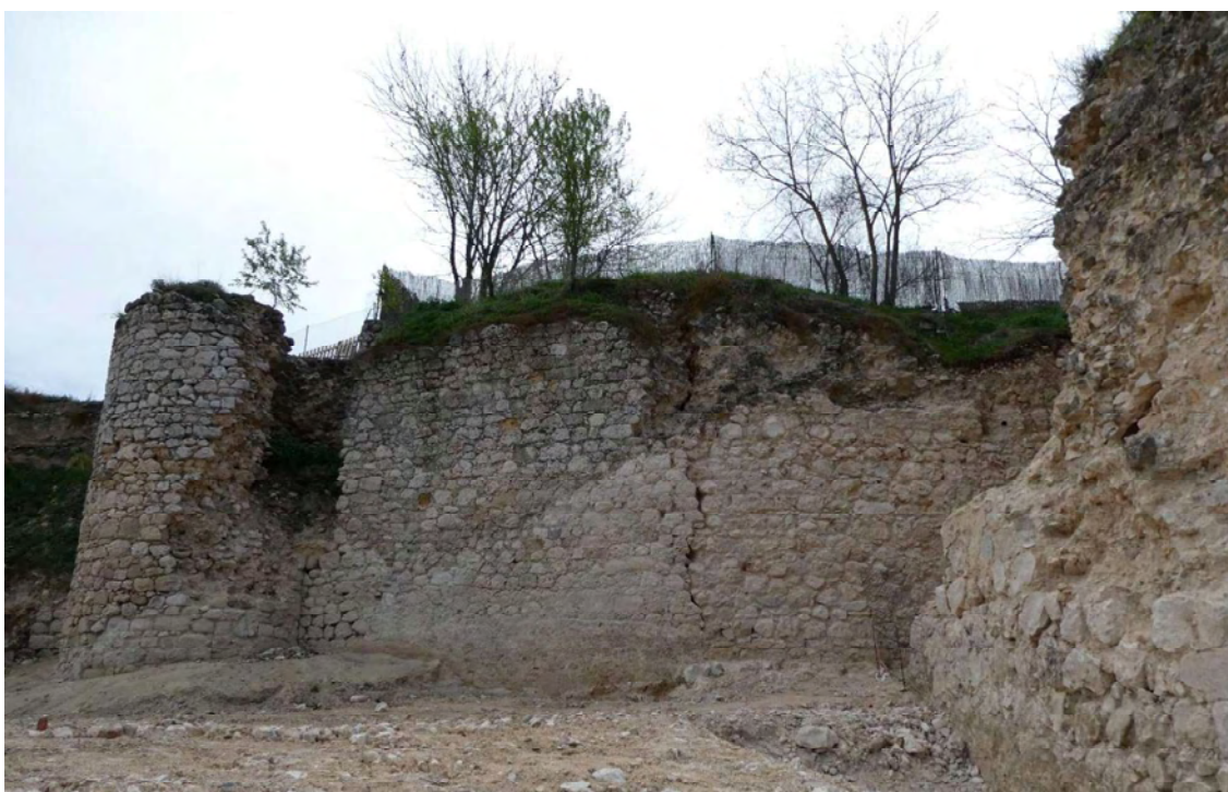
QUI002. Enmugrecimiento en el lienzo de muralla que no estaba enterrado y en el núcleo central de la torre albarana.
