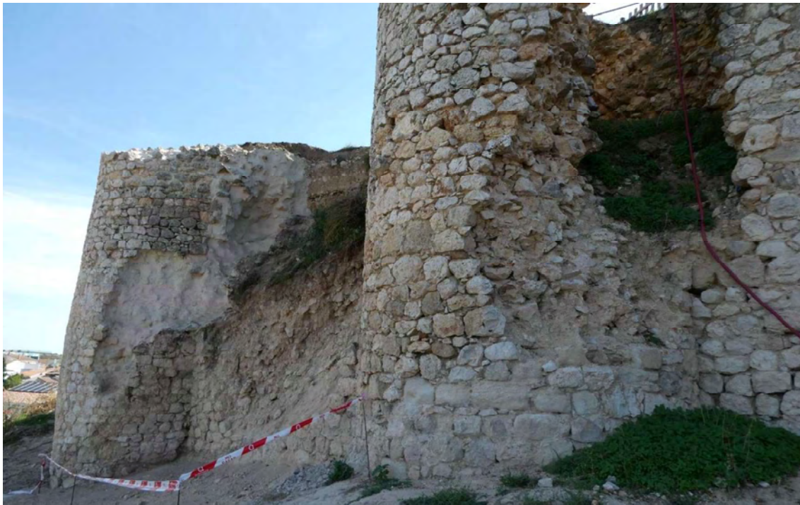
A la derecha, el primer torreón donde puede verse el enjarje perdido y a la izquierda el segundo torreón tras la actuación de emergencia.
