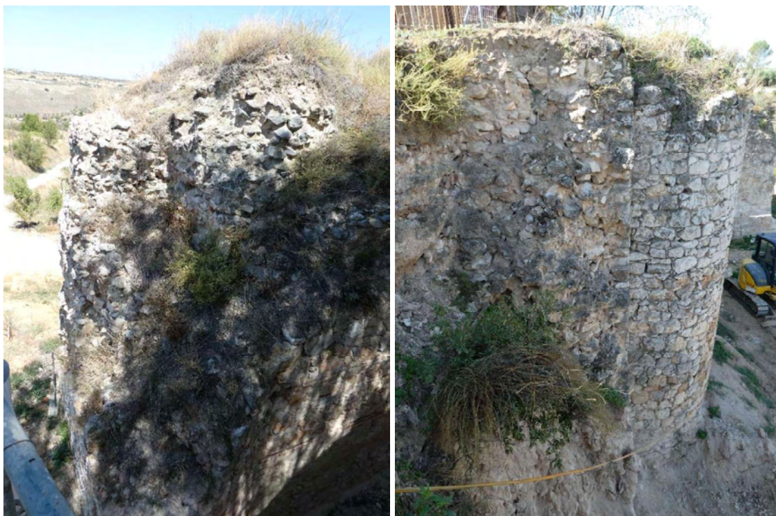
QUI001. Crecimiento de vegetación en coronación de torreón circular y torre albarrana
