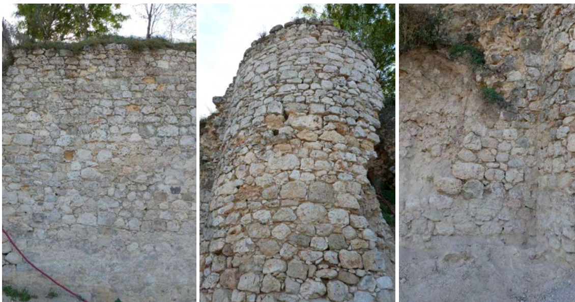
En estas fotografías se pueden ver los aparejos que posee la muralla en el tramo que se interviene. La primera pertenece al lienzo 5 de mampostería concertada, la segunda al primer torreón circular y la tercera al lienzo entre torreones parcialmente desaparecido.
