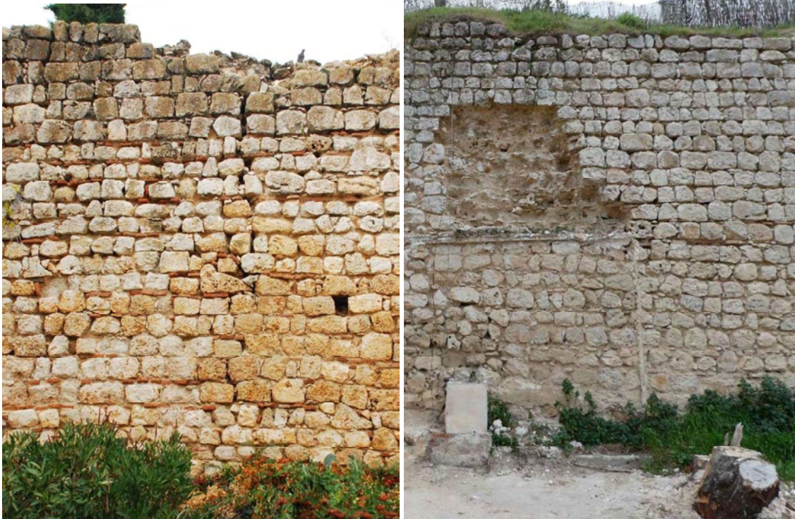
La primera imagen pertenece al lienzo oriental ligado al torreón poligonal, en la segunda imagen se ve el lienzo del tramo 4 que acomete a la Torre Hueca o Albarrana previo a la actuación de 2023, ambas realizadas en sillarejo.
