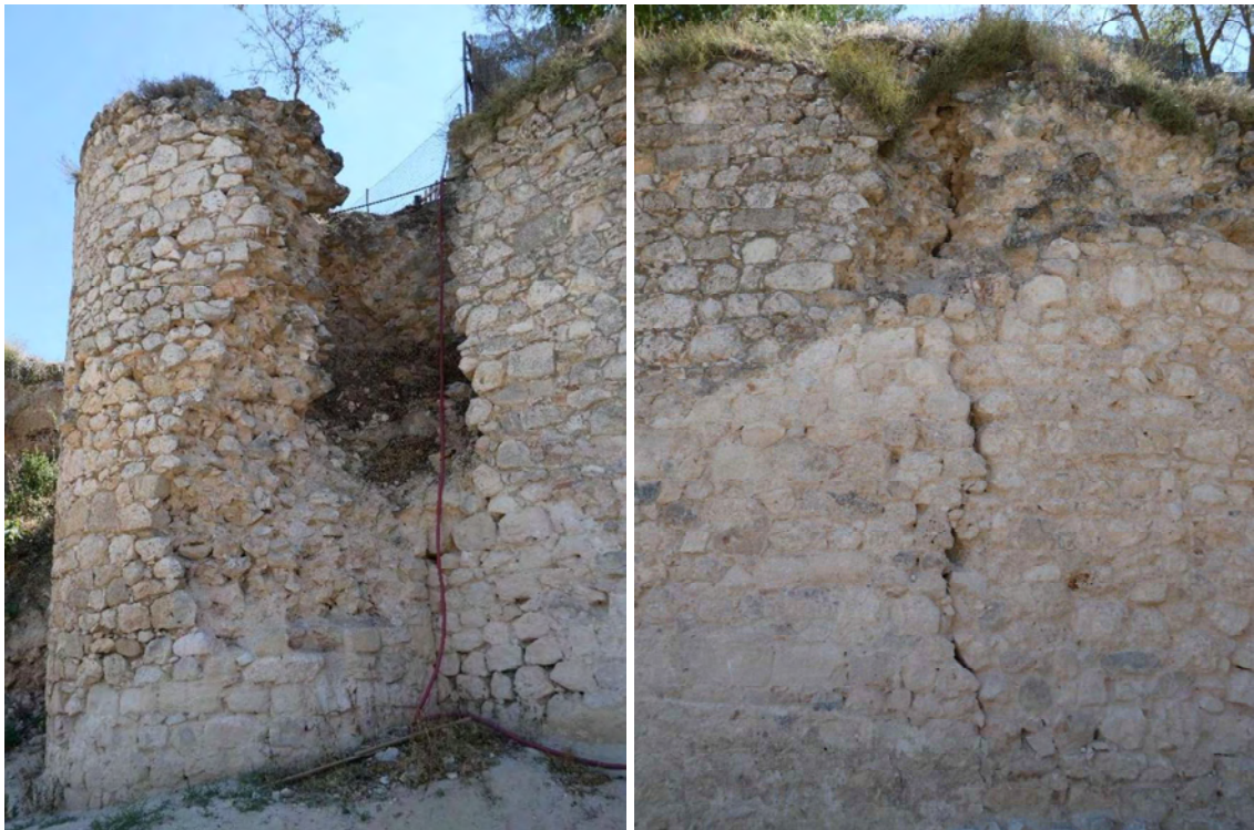
MEC 001. Faltantes pétreos en el enjarje entre lienzo y primer torreón circular. MEC002. Grieta vertical en lienzo
