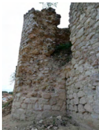
Encuentro entre torresón circular y benzo. Pérdida parcial de los componentes
