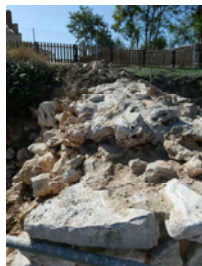
Corrosión de los torresones circulares. Faltantes. Disgregación de mortero y elementos pétreos
