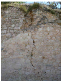
Linea de mampostería. Grietas verticales sobre la hoja exterior y núcleo
