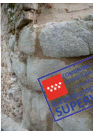
Linea de mampostería, encuentro con Benzo 4. Extremo de alfiler. Pérdida y disgregación de material
