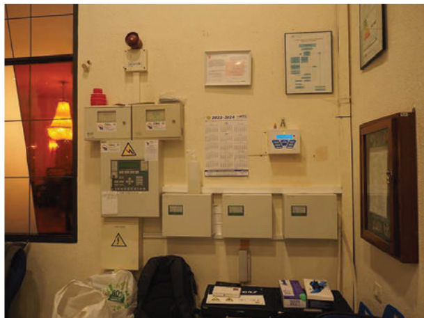
Central y fuentes de alimentación en puesto de control
