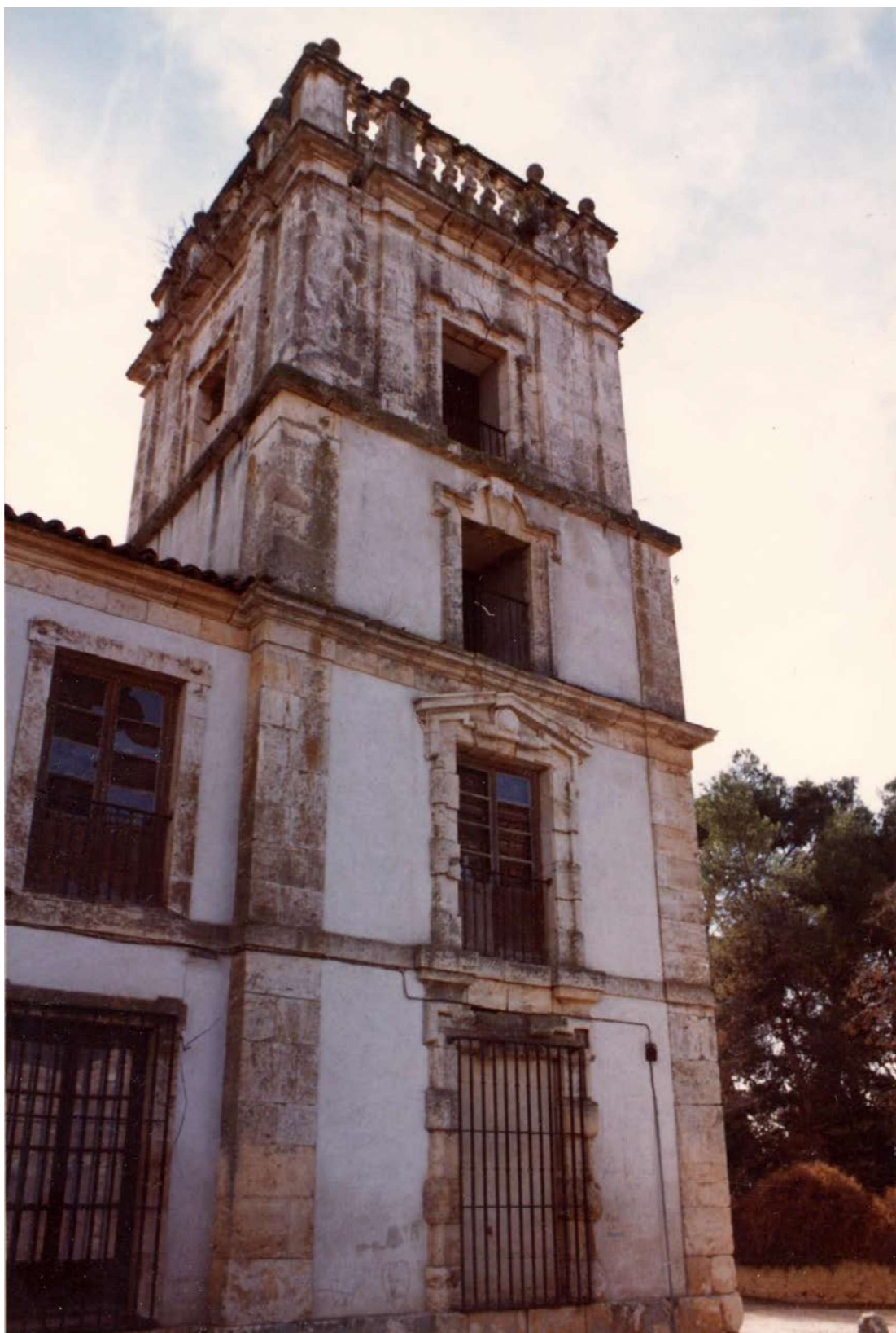
Torreón norte del Palacio. Se pueden ver los paños con revoco y el estado de las impostas, cornisas y resto de elementos de piedra caliza.
