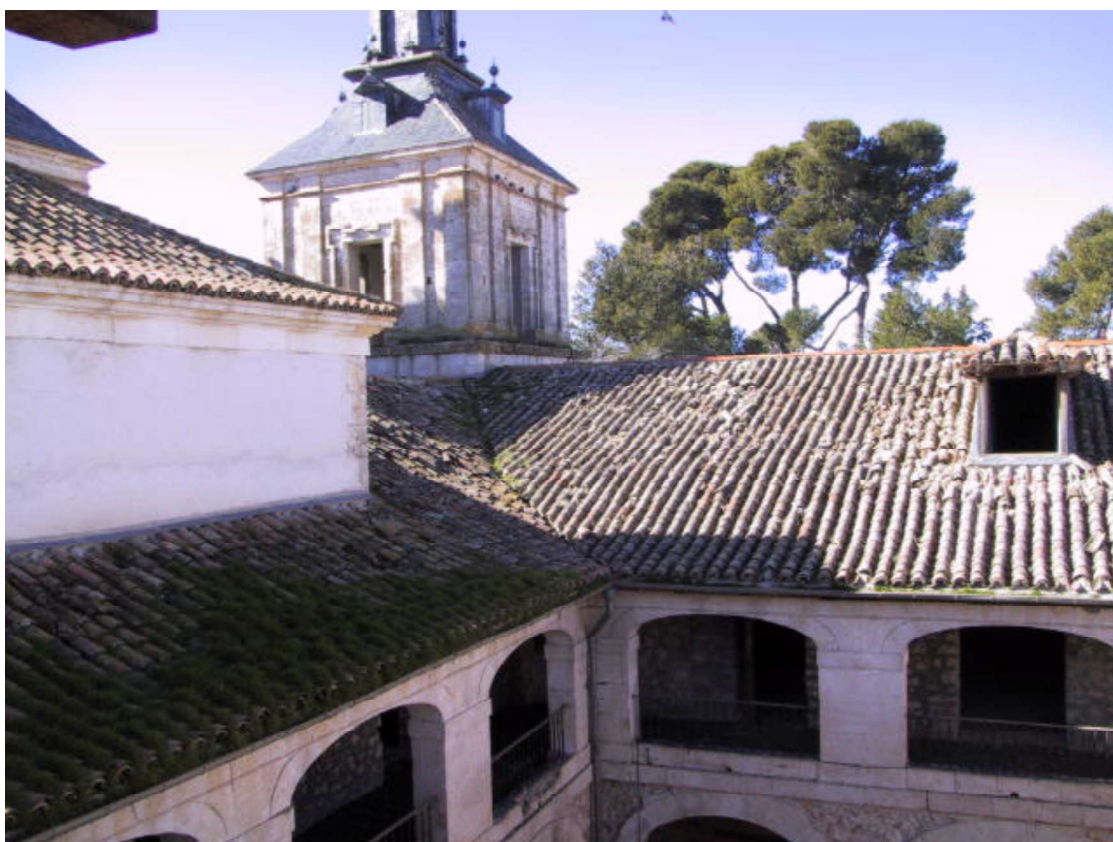
Ya en 2002 se aprecian importantes deterioros en la cubrición de teja árabe.
