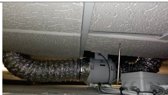
UBICACIÓN EXTRACTOR DE C. TÉCNICO 6 EN EL FALSO TECHO
