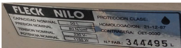
UBICACIÓN Y PLACA CARACTERÍSTICAS DE TERMO ELÉCTRICO DE LA PLANTA SEMISÓTANO
