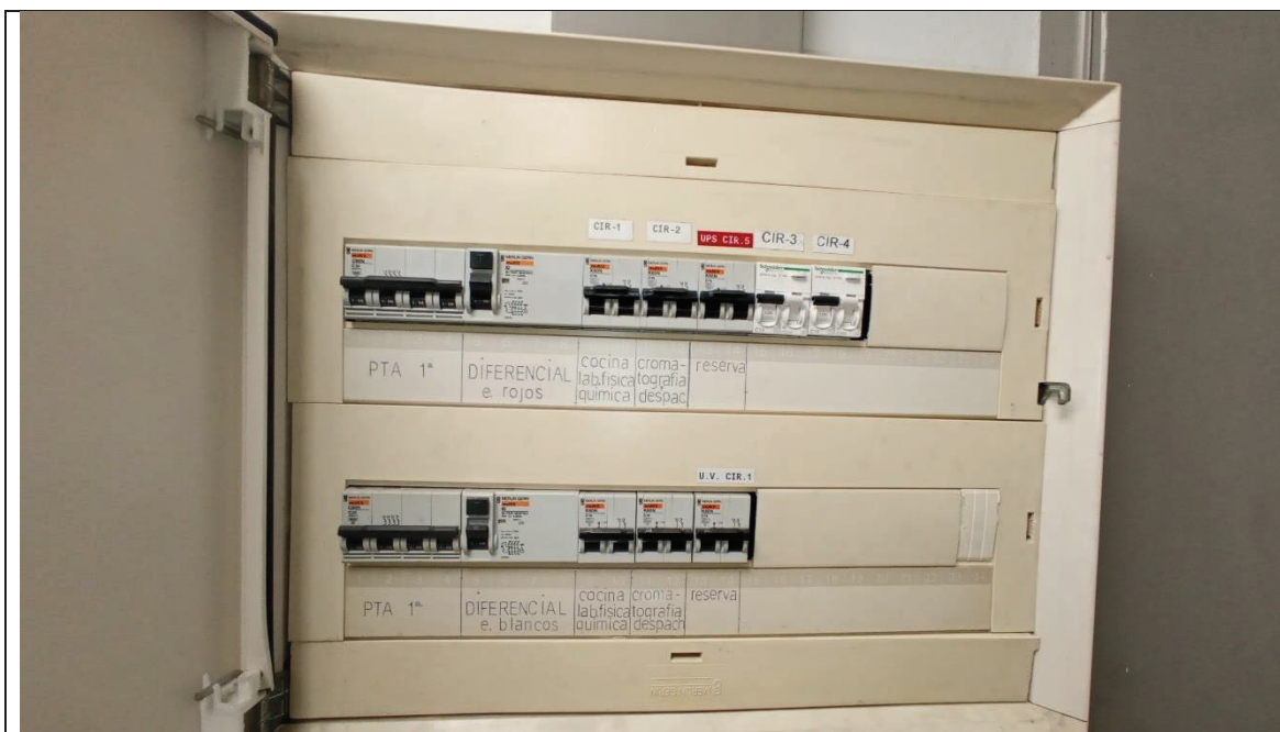
Imagen 11: Distribución elementos en Cuadro Eléctrico Enchufes Informática.
