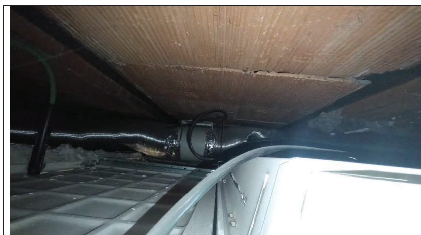
UBICACIÓN EXTRACTOR DE C. TÉCNICO 1 EN EL FALSO TECHO
