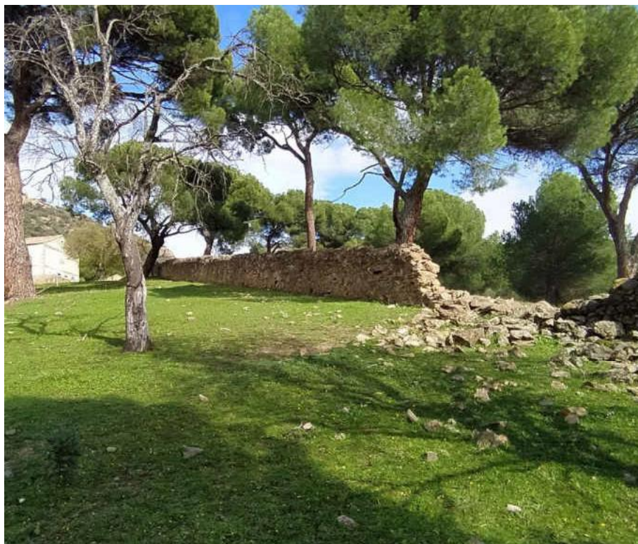
Tramo derruido en muro de mampostería.
