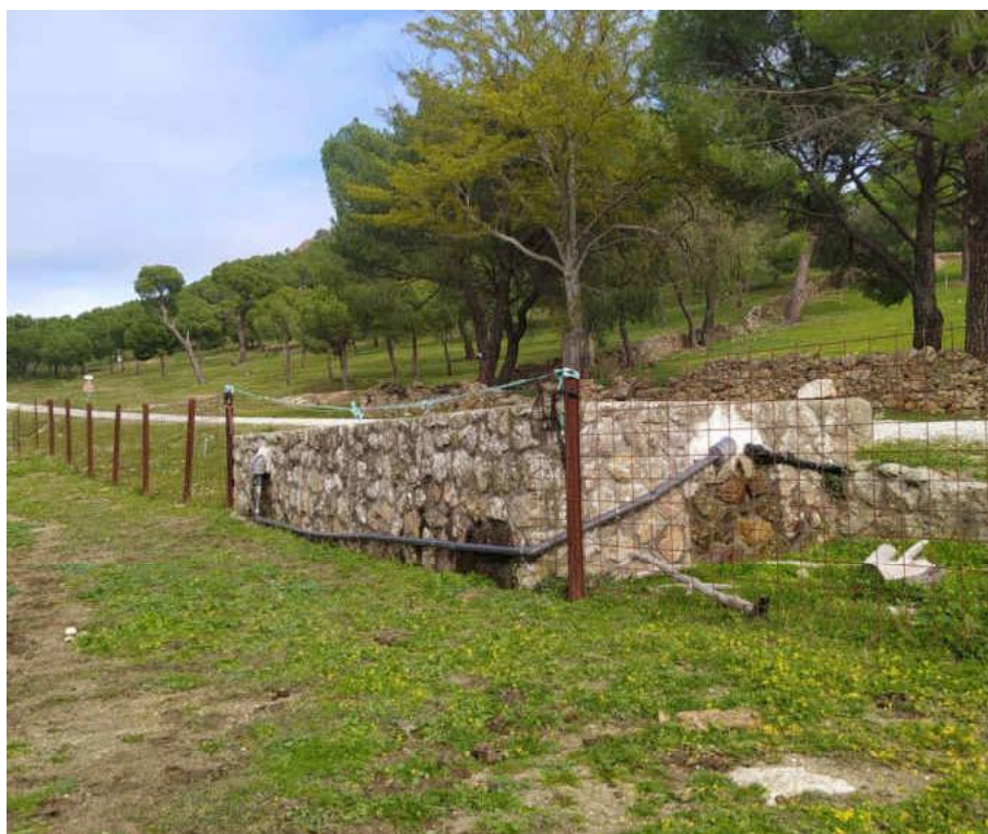
Depósito de agua con acometidas donde son visibles las fugas de agua
