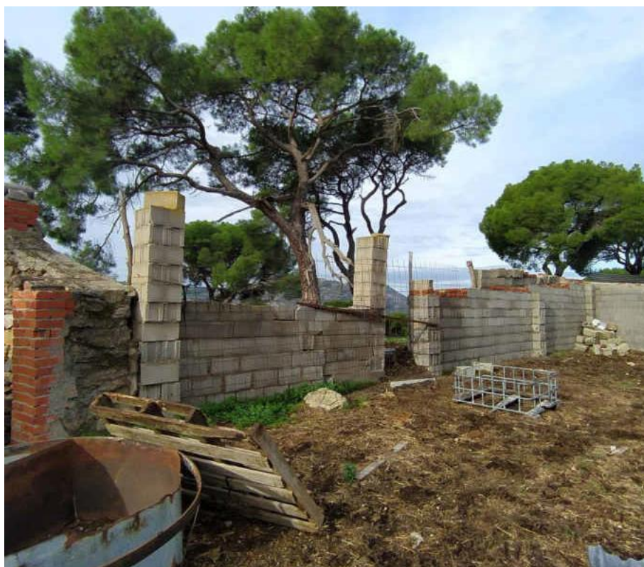
Cerramientos de los corrales, en mal estado, realizados en fábrica de bloques de hormigón.
