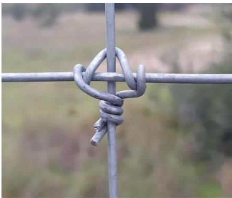
El nudo tipo bravo o “fixed knot” aporta resistencia extra a la malla ganadera.
