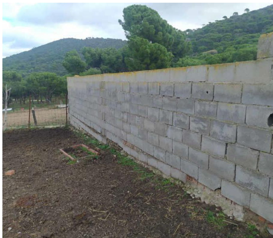
Muros de los corrales realizados en bloques de hormigón y faltos de cimentación que no son estables a los empujes del ganado.
