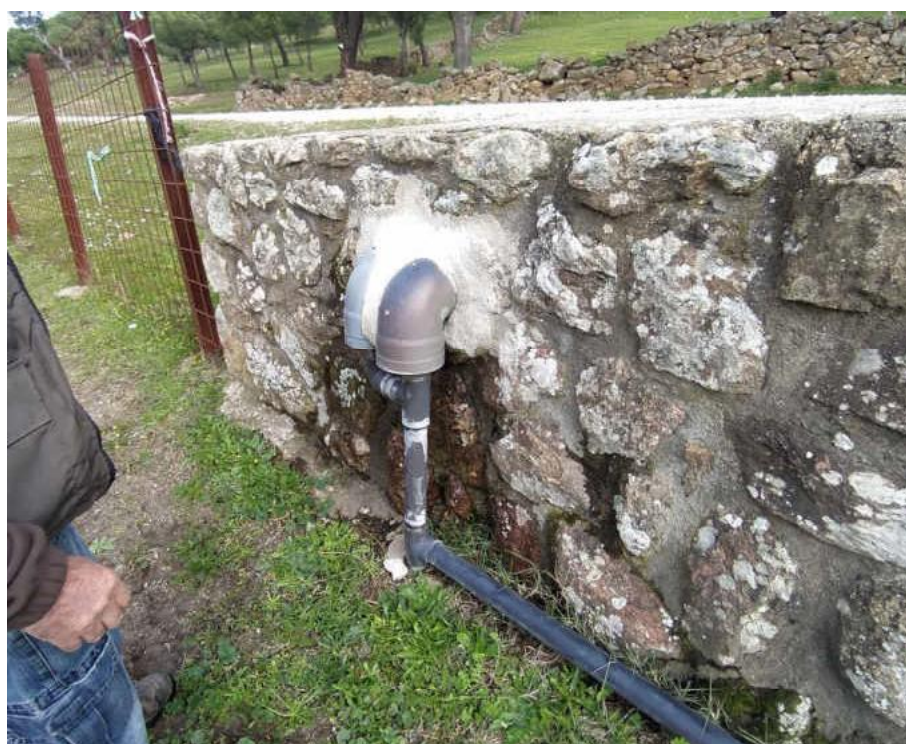
Detalle de las fugas de la acometida realizada para el aliviadero.
