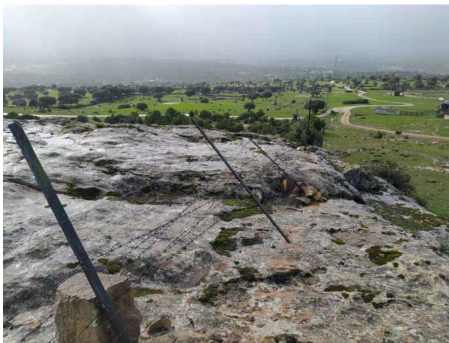
Cerramiento sobre roca con postes doblados por embestidas del ganado
