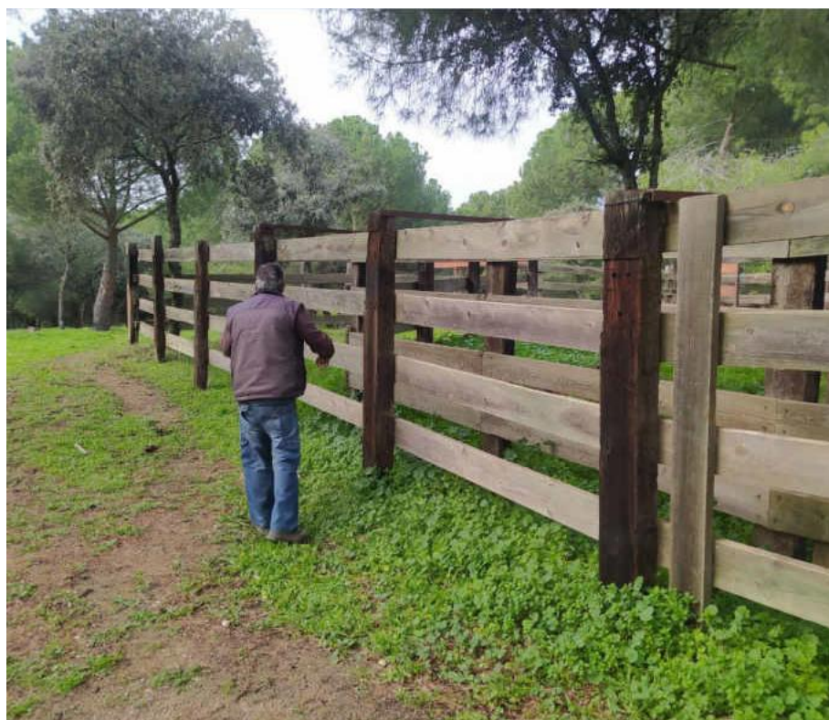
La manga y los corrales tienen algunos postes y tablas con pudriciones que necesitan ser sustituidos.
