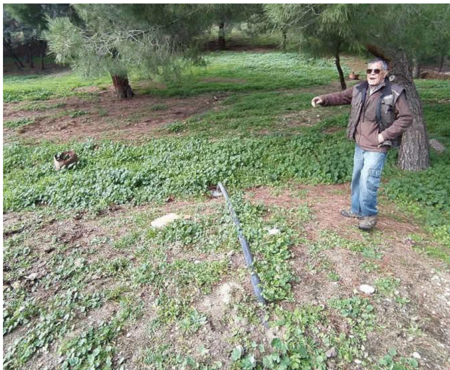
La canalización incompleta del aliviadero al verter en el corral provoca encharcamientos peligrosos para el ganado y los trabajadores.
