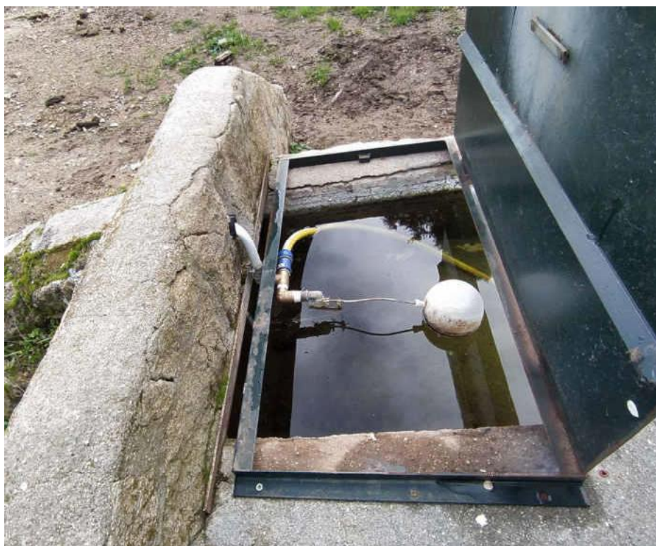
Sistema de regulación del agua en depósito, realizado con mangueras de riego.
