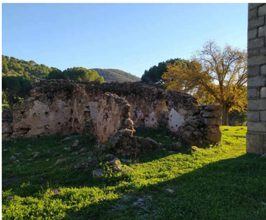
Edificaciones en ruinas a derruir para para mejorar el paso, la seguridad y obtener piedra para la restauración del muro.
