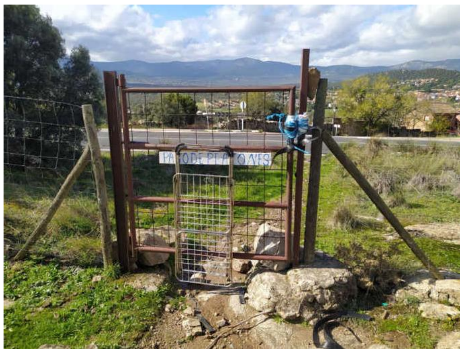
Puerta con elementos de fortuna añadidos. El sistema de cierre con cuerdas provoca que los excursionistas menos considerados dejen la puerta abierta con el riesgo de salida del ganado hacia la calzada.
