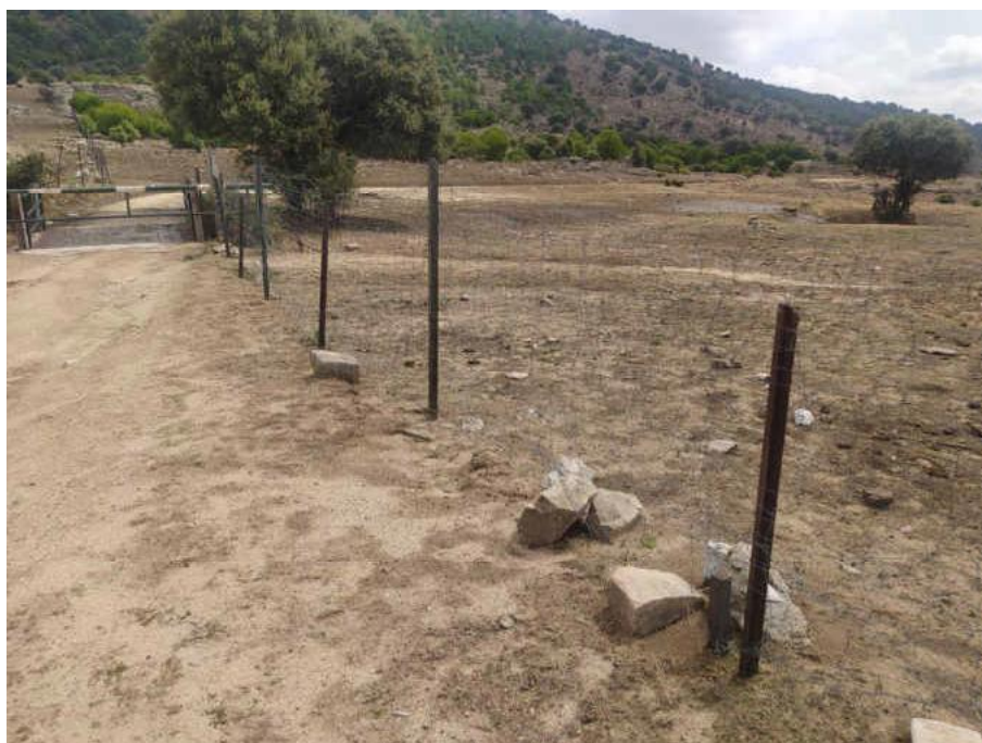
Tramo de cerramiento junto a puerta en límite sur del monte, con malla en mal estado.
