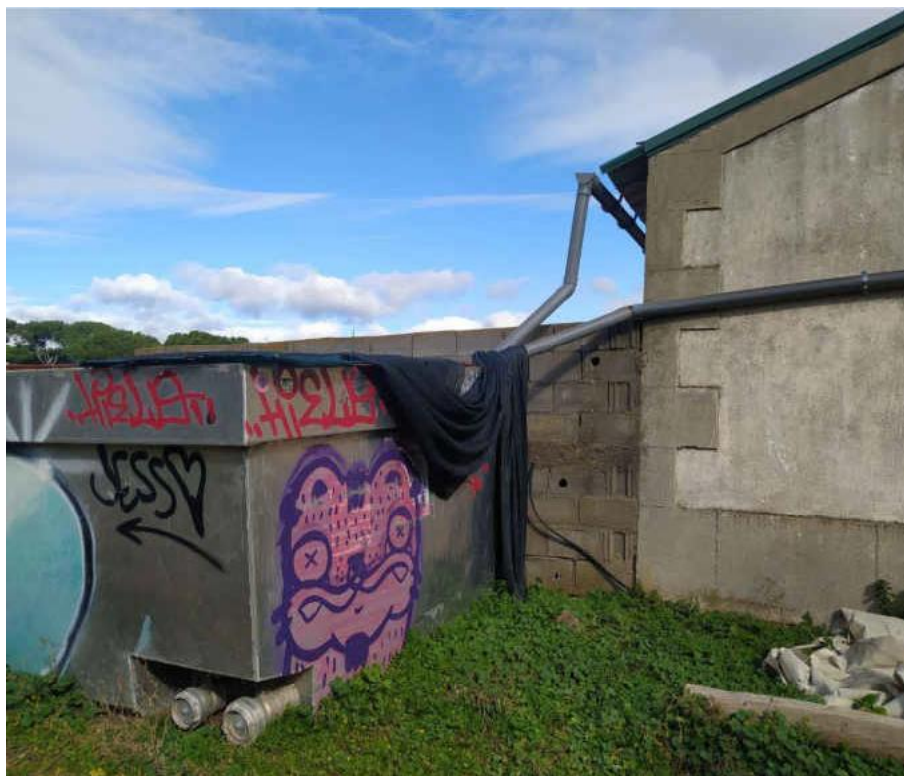
Canalización de los pluviales de la cubierta hacia el depósito para su aprovechamiento.
