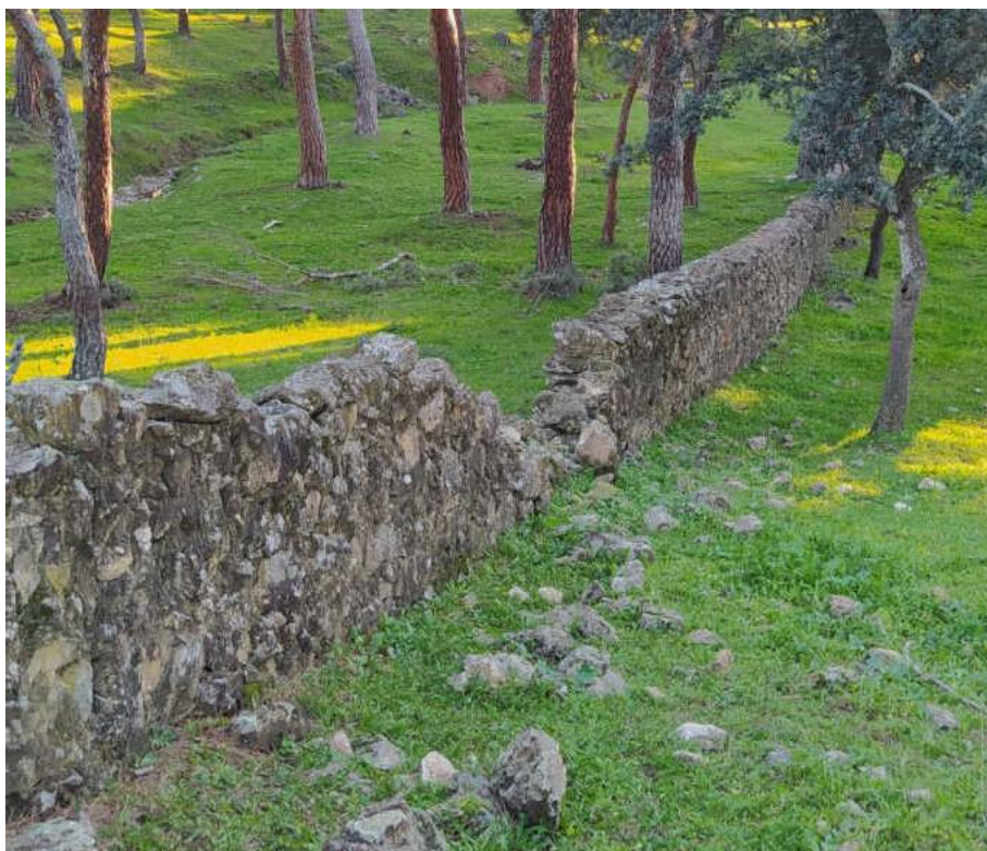
Vista de rotura en muro.
