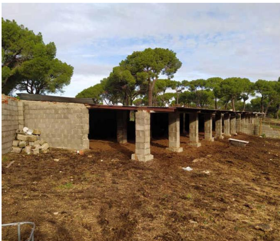
Vista de la nave realizada con bloques de hormigón
