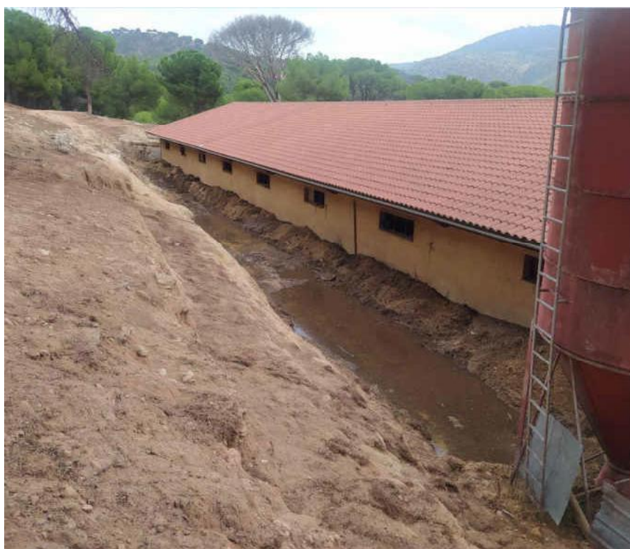
Encharcamiento en el muro norte de la nave provocado por la falta de drenaje de la escorrentía de la ladera
