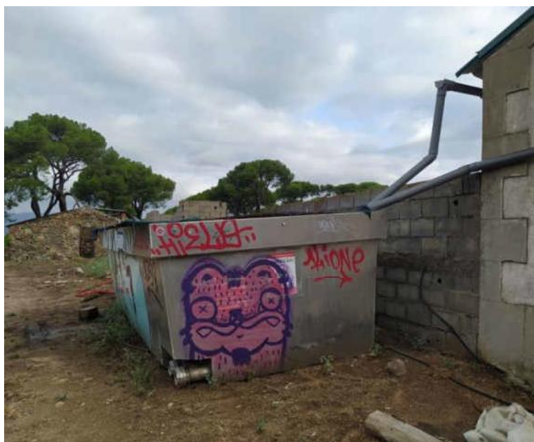
Depósito de agua existente que permite aprovechar las pluviales de la edificación contigua.
