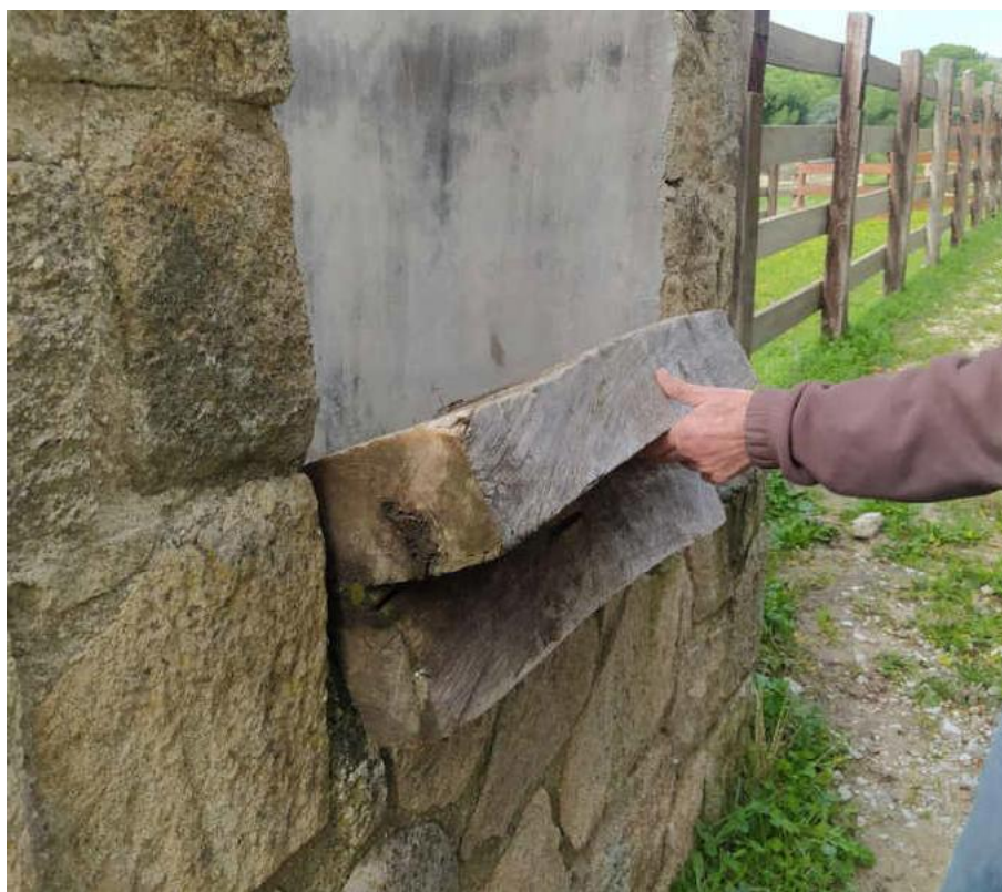
Elemento de madera utilizado para evitar el hueco que se forma entre el camión y la rampa
