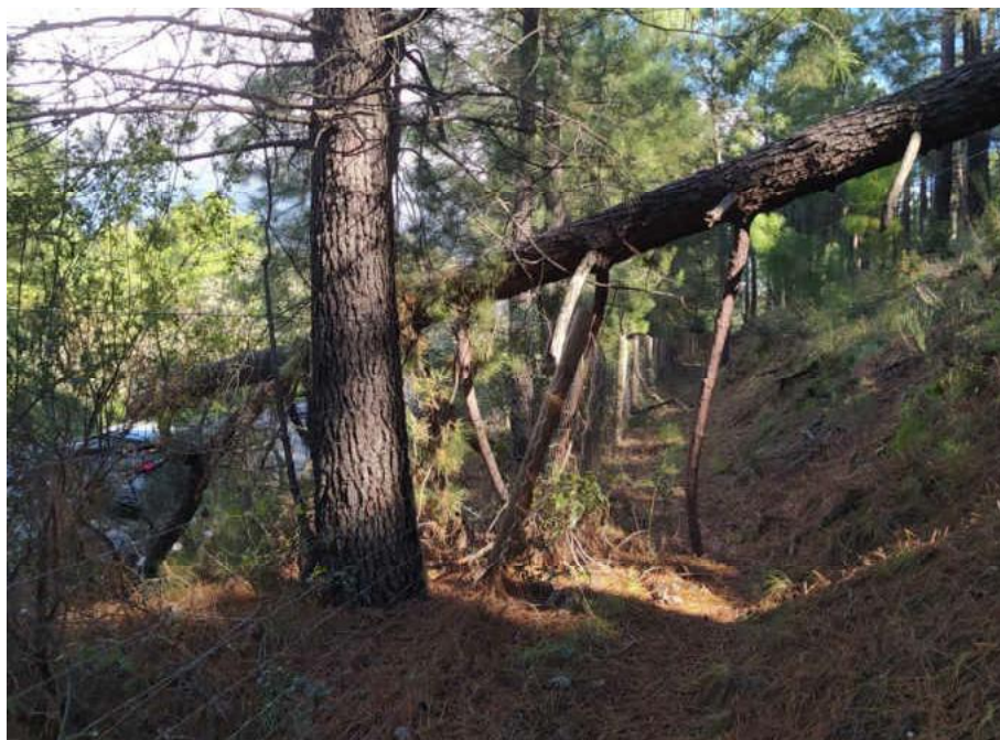
Cerramiento dañado por pino caído que debe retirarse y sustituir el poste de madera roto.
