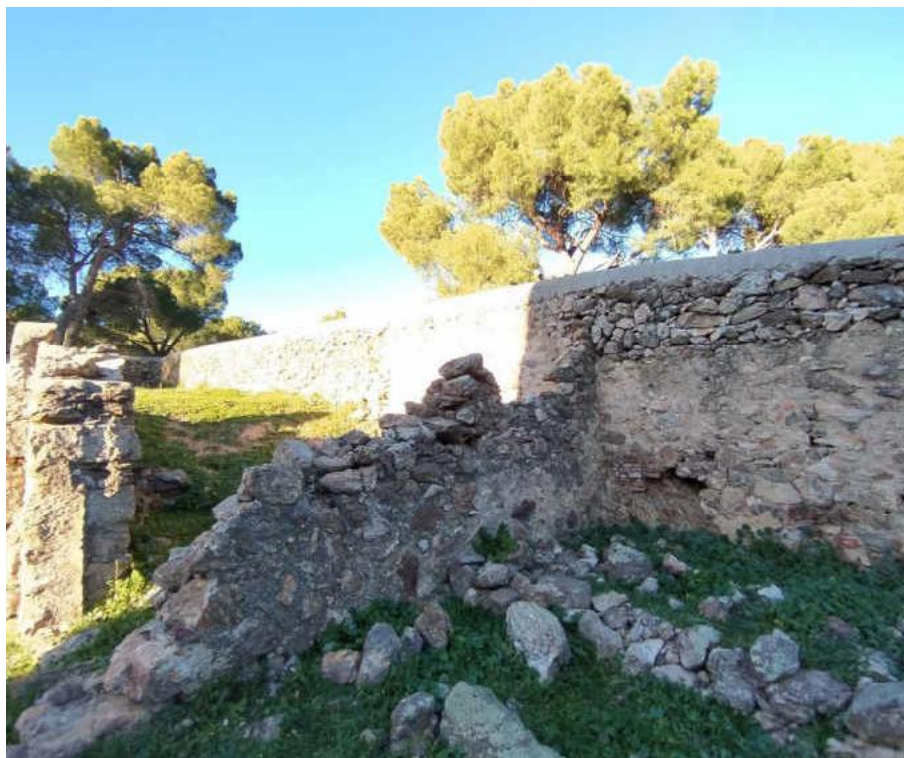
Contrafuerte derruido que precisa reparación
