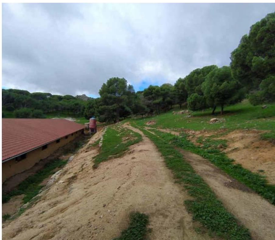
En el camino sobre la ladera se ha proyectado una cuneta de guarda para reducir y reconducir la escorrentía de la ladera.
