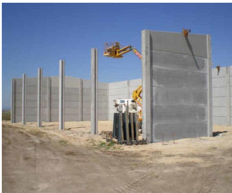
Trabajos de montaje de elementos prefabricados en nave agrícola
