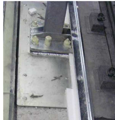
Ejemplo de fijación pilar a refuerzo borde de andén (en naranja) mediante soldadura (en verde) y base de pilar (en azul) atornillado a él.
