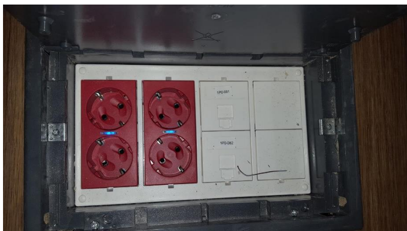
Figura 5 – Puesto de trabajo 2TT+4EE+1MC
