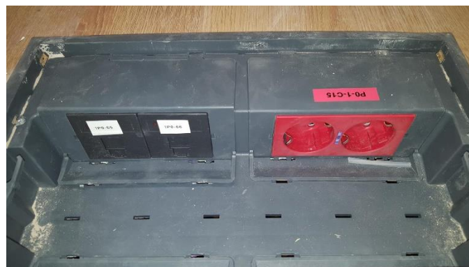
Figura 4 – Caja con mecanismos en vertical y detalle de los mismos
