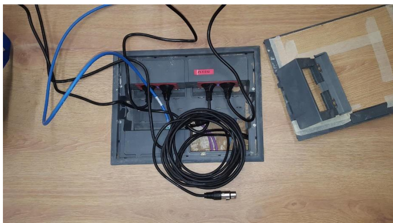
Figura 10 – Cableado de micrófono en sala de vistas
