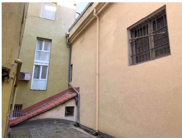
F62, 63 y 64. Arriba, vista de la fachada sur de la capilla por encima de la sacristía, detalle de las bajantes y el estado del pesebrón en el que evacúan. Abajo, zona del paramento sur de la capilla coincidente con el pesebrón de arriba. Presenta deterioros visibles aunque aparentemente está seca.
