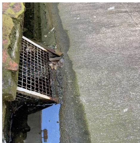
F62, 63 y 64. Arriba, vista de la fachada sur de la capilla por encima de la sacristía, detalle de las bajantes y el estado del pesebrón en el que evacúan. Abajo, zona del paramento sur de la capilla coincidente con el pesebrón de arriba. Presenta deterioros visibles aunque aparentemente está seca.
