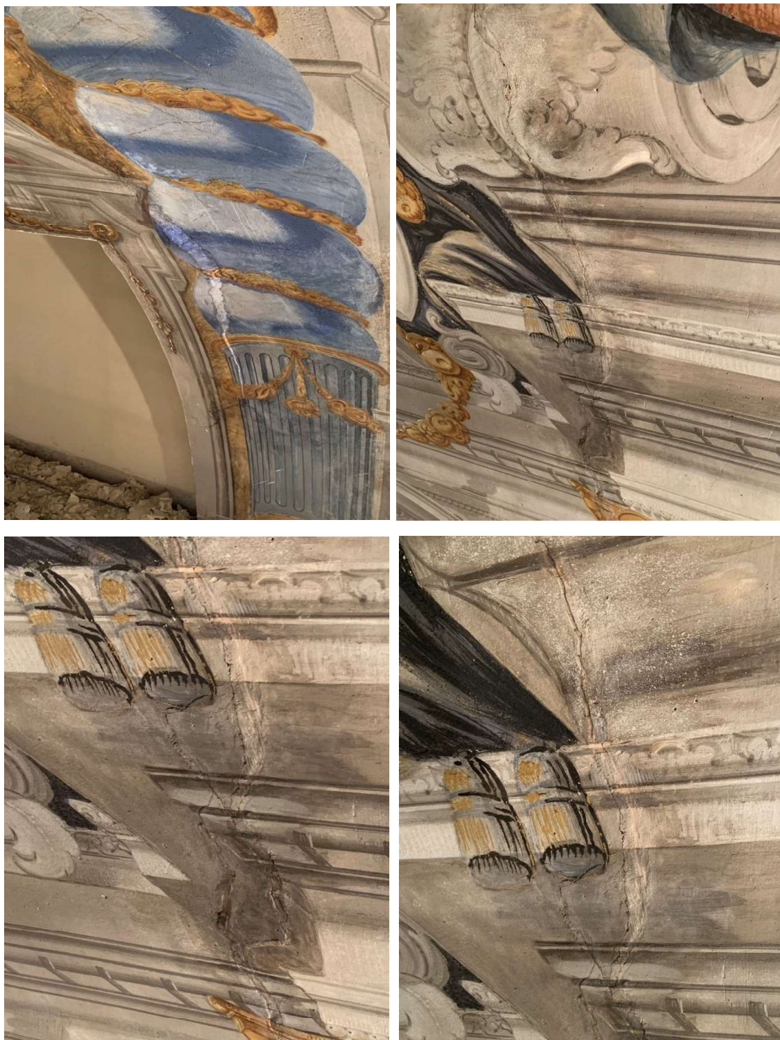
F110, 111, 112 y 113. Estas imágenes corresponden a una grieta abierta en el testero oeste con una deformación significativa a su curso junto al vano cegado. Tal como se aprecia en la fotografía superior izquierda, la grieta se selló en un primer momento para retocarla, y permanece cerrada. Lo interpretamos también como señal de estabilización en este paño de bóveda. Vamos reconociendo su recorrido repintado según asciende la grieta. En la fotografía de arriba a la derecha se advierte, en la moldura superior de la fingida cornisa, que se han tratado de retirar los burdos repintes, y la capa pictórica original aparece lesionada. Probablemente la solubilidad de la pintura original en esta zona dificultaba la tarea, y se cesó en el propósito, manteniendo los burdos repintes que continúan hacia abajo. En los dos detalles inferiores de la misma zona advertimos que simplemente se han tratado de disimular, restringiendo la retirada de repintes por un lado, y por otro, realizando una reintegración de regatino ceñida a la masilla de relleno. Por las características de esta actuación, sin duda corresponde a la intervención realizada en 1985.
