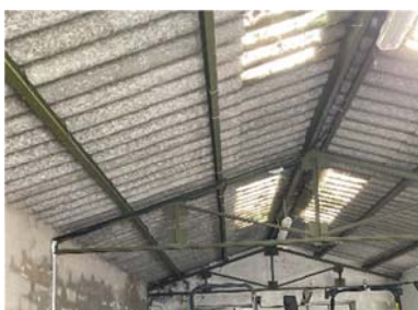
Cubierta de fibrocemento apoyada sobre cerchas
