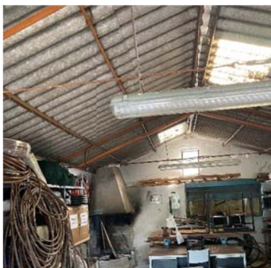
Cubierta de fibrocemento apoyada sobre estructura ligera, algunas correas sobrecargadas
