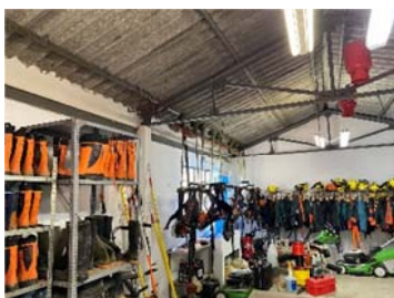
Cubierta de fibrocemento apoyada sobre cerchas
