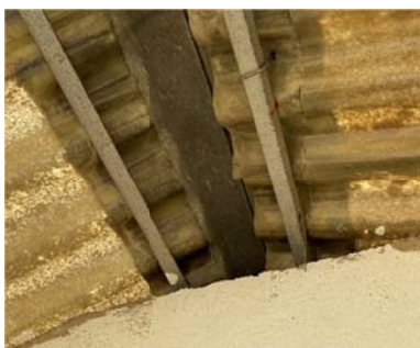
Cubierta de fibrocemento apoyada sobre estructura ligera, algunas correas sobrecargadas
