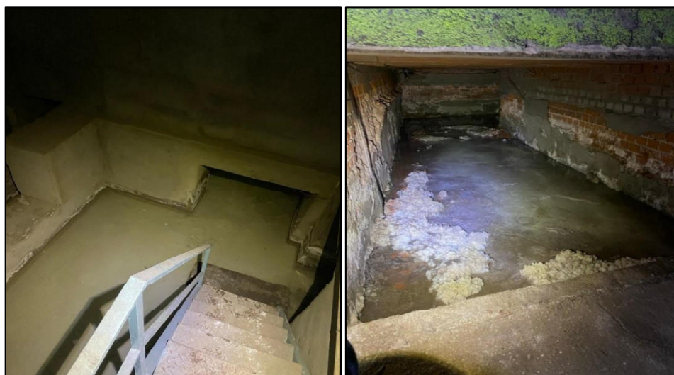
Figura 2. A la izquierda, escalera de acceso al bajo andén de Andén 2 San Fernando. A la derecha, mismo bajo andén con daños en muros y enfoscados.
