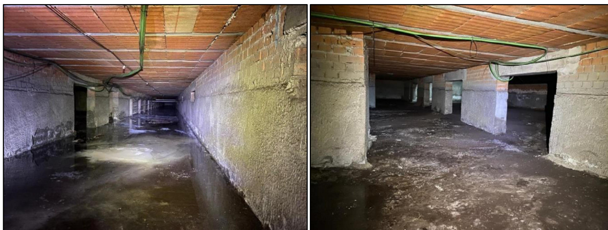
Figura 3. Vistas del bajo andén (Andén 1) de La Rambla. A la izquierda, se aprecia la inundación parcial del bajo andén en la zona próxima al dren longitudinal. A la derecha, estado general del bajo andén. Compárese con sus homólogos en San Fernando y Coslada Central.
