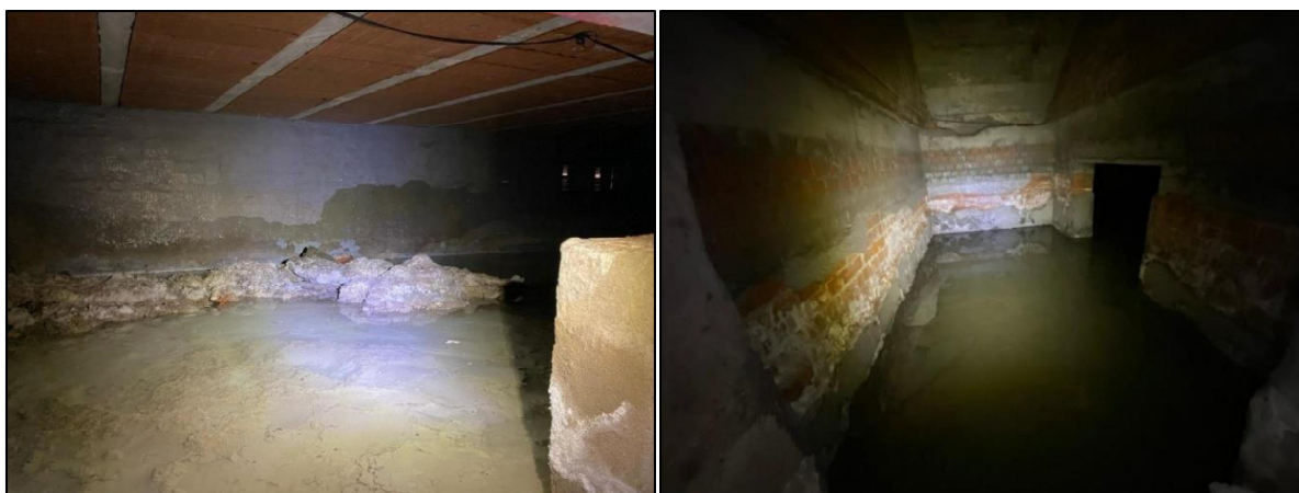
Figura 1. Fotografías realizadas en los bajo andenes de Andén 1 San Fernando y que muestran cómo las cámaras están completamente inundadas y presentan acumulación de sales.
