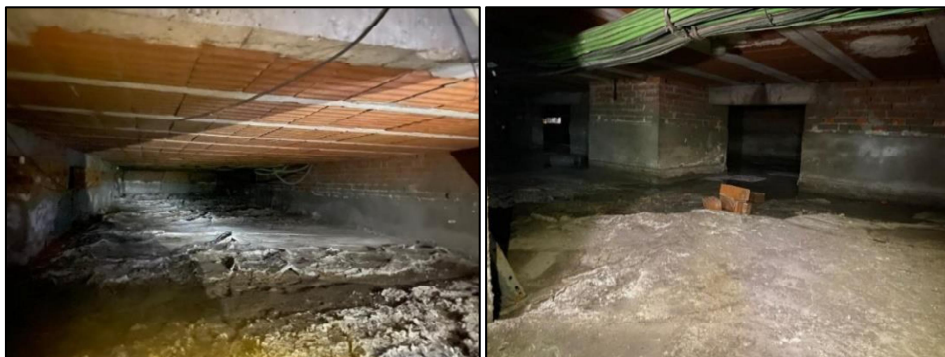
Figura 4. A la izquierda. Bajo andén de Andén 2. Se observa el daño producido por sales en la solera. En la otra imagen, bajo andén 1 con inundación parcial.
