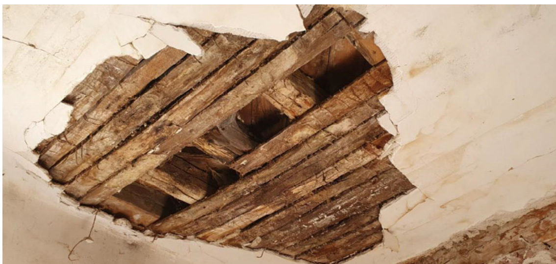
Forjado de la crujía sur en su esquina occidental.
