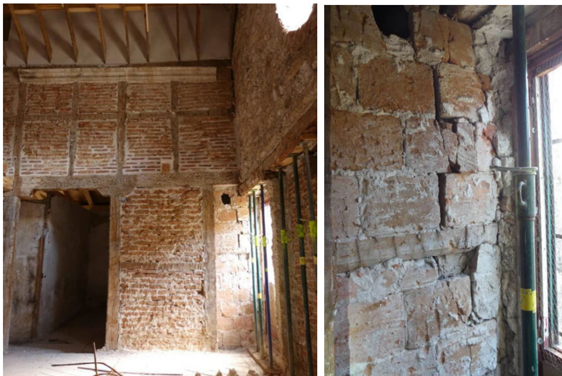
Muro de entramado sur de la primera planta, en la capilla. Mal estado del muro a panderete del extremo occidental.
