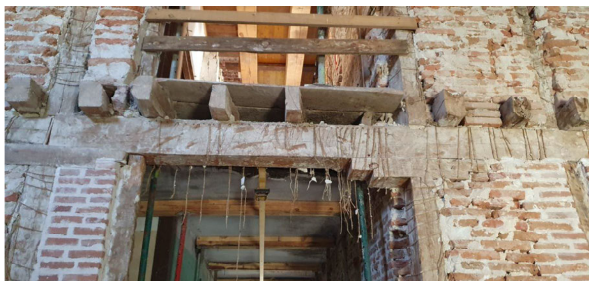
Cabezas de las viguetas del forjado norte.
