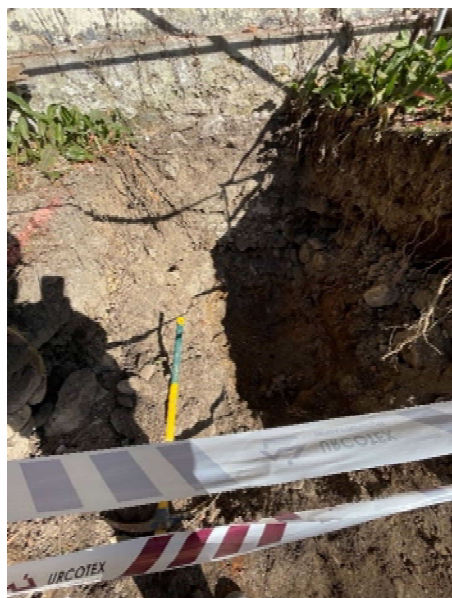
Figura 28. Detalle del terreno de apoyo en calicata C-2
