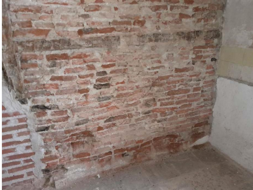
Figura 11. Degradación por humedades.
