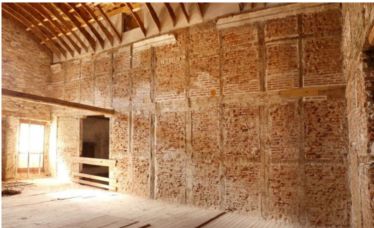
Muro de entramado norte. Primera planta, capilla.
