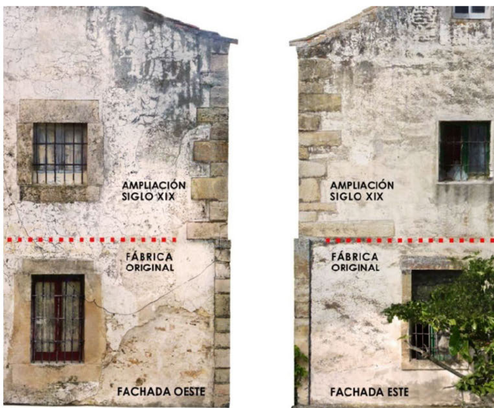
Diferente morfología y composición de las esquinas del convento. Detalles de las fachadas este y oeste.
