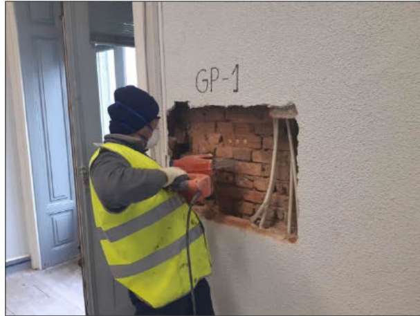
Figura 35. Corte en el muro.
