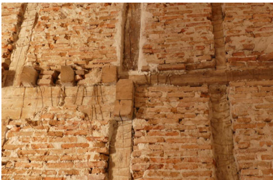
Detalle del cambio de la dirección del forjado de la nave norte en su extremo oeste. Cabeza de la viga de borde de 40*20 de escuadría, que sustentaba el forjado. Habría un pilar para acortar la luz.
