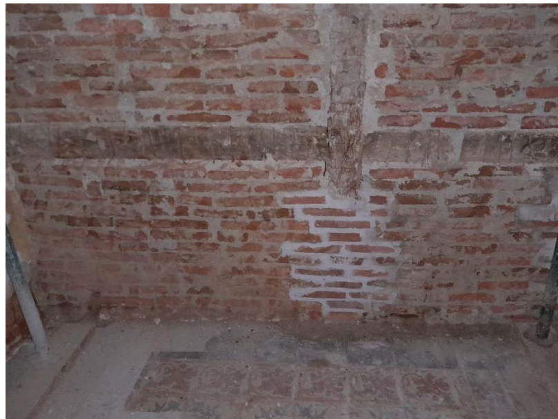
Figura 10. Refuerzo de pie derecho con ladrillo.
