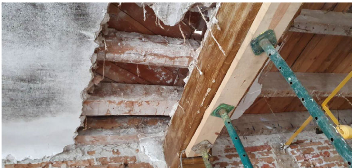
Forjado de la crujía sur en su esquina occidental.
