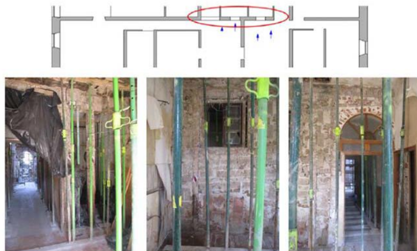
Figura 4. Muros con huecos. Fuente: Documentación facilitada: documento 2.
