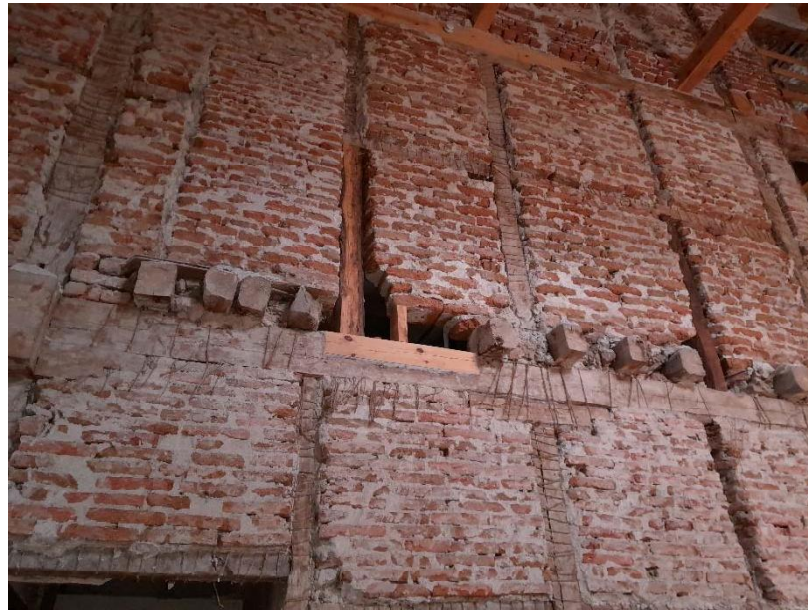
Figura 9. Vigas y pies derechos cortados y repuestos.
