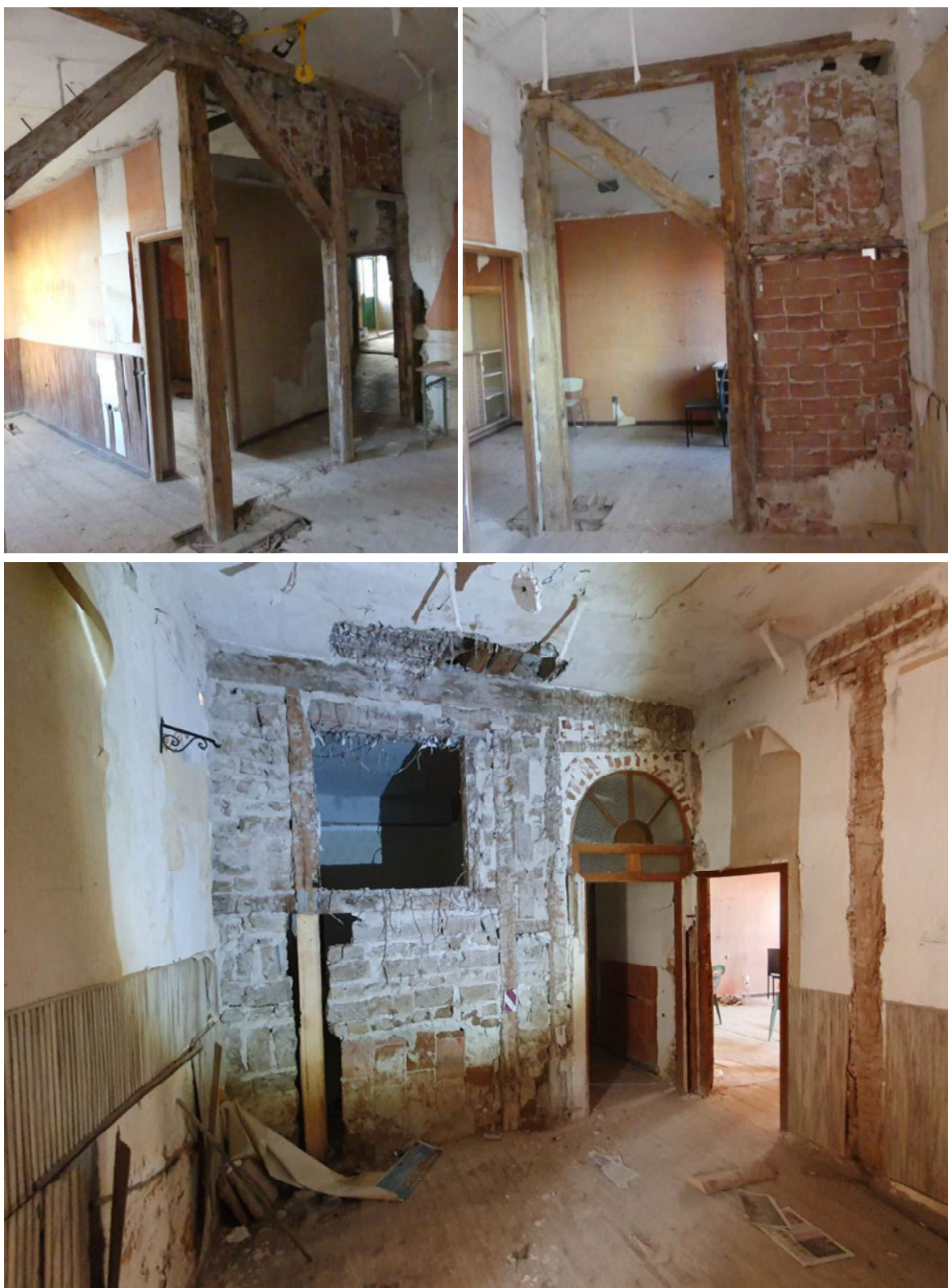
Parches y modificaciones en la crujía sur de la planta baja del muro de entramado. Zona central y oriental.
