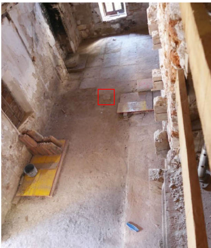
Vista del pavimento original de la zona norte. Se destaca la basa de granito del pie derecho que acortaba la luz de la viga de borde del forjado.
