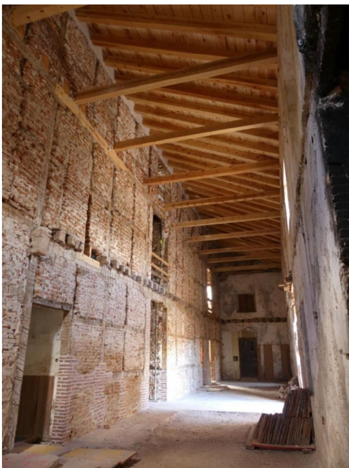
Nave norte. Muro de entramado de la crujía central.
