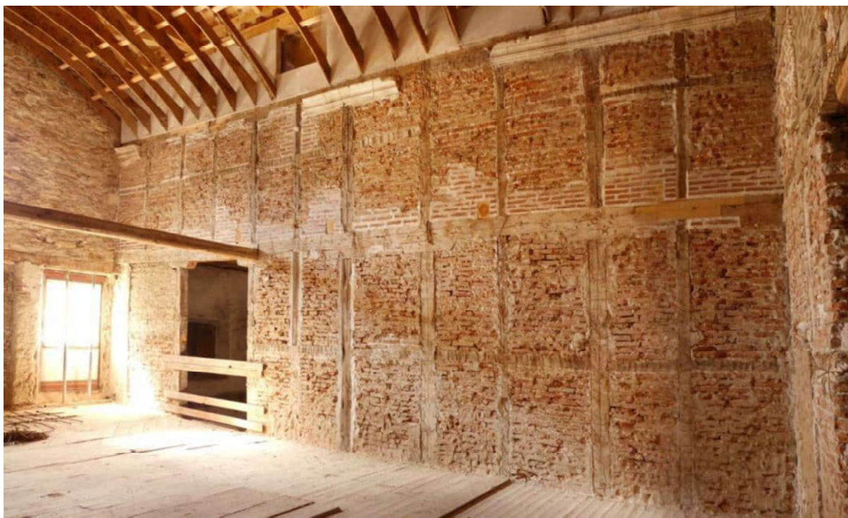
Muro de entramado norte. Primera planta, capilla.
