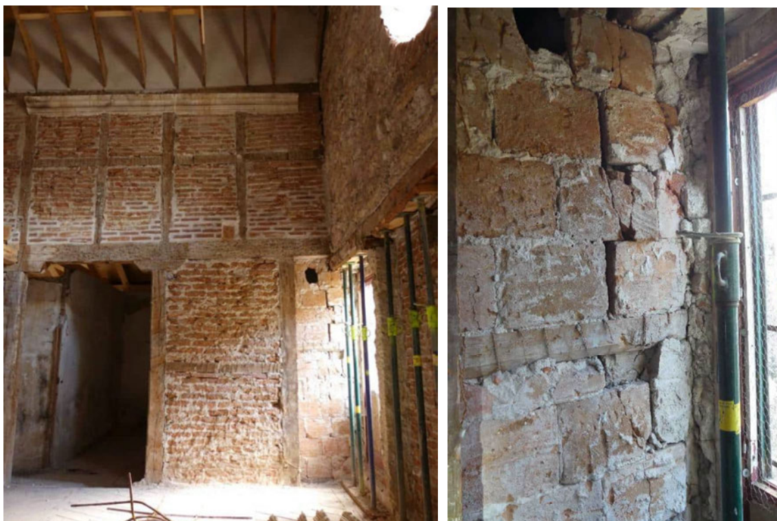
Zona central de la crujía sur de la planta baja del muro de entramado.
