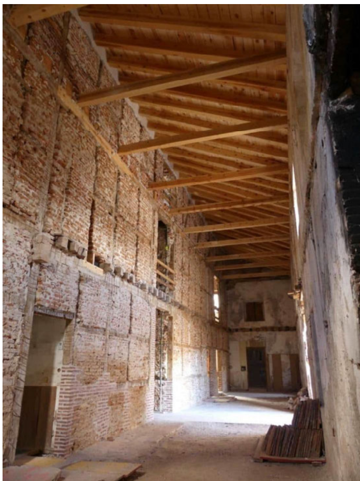
Nave norte. Muro de entramado de la cruzía central.
