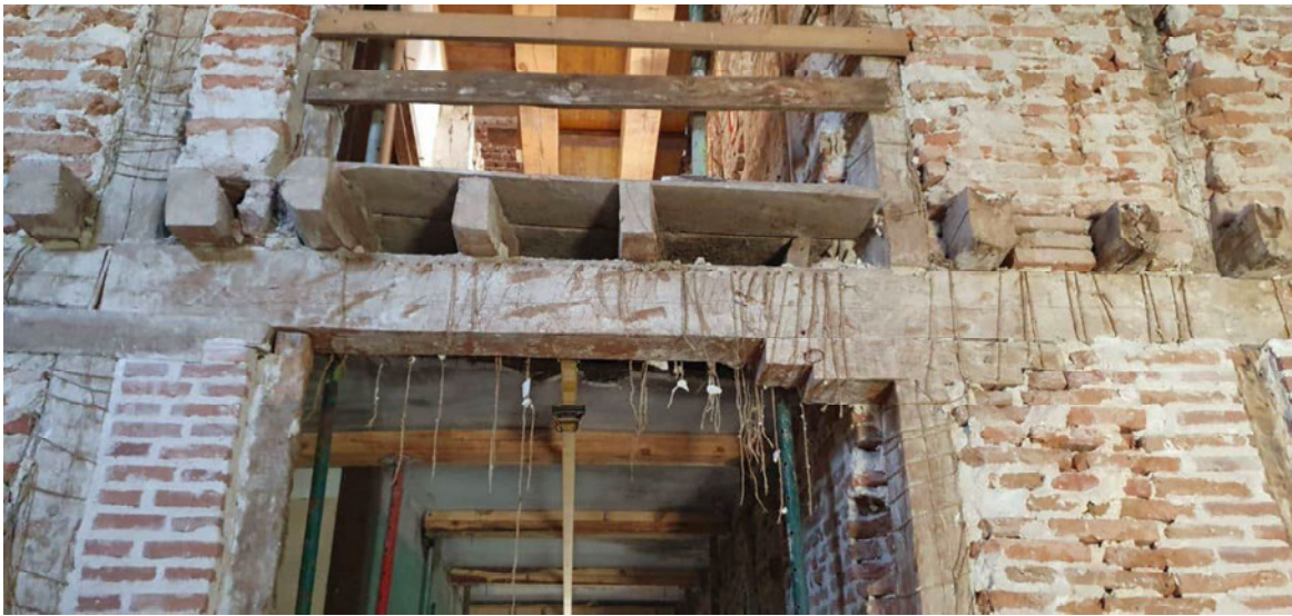
Cabezas de las viguetas del forjado norte.
