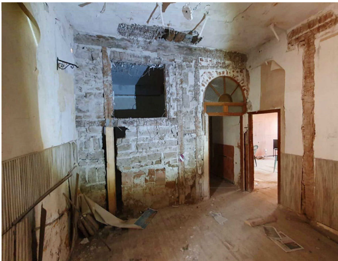
Parches y modificaciones en la crujía sur de la planta baja del muro de entramado. Zona central y oriental.
