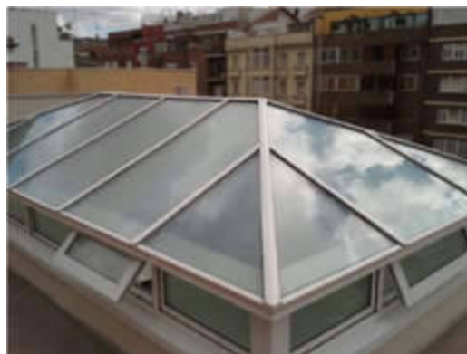
Figura 59- Ejemplo lucernario con ventilación vertical
