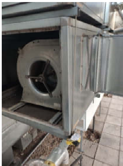
Figura 35- Ventilador sin aislar
