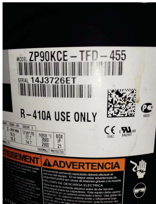
Compresor Copeland™ ZP R410A scroll: ZP90KCE-TFD-455 con Nº Serie: 14J3726ET
