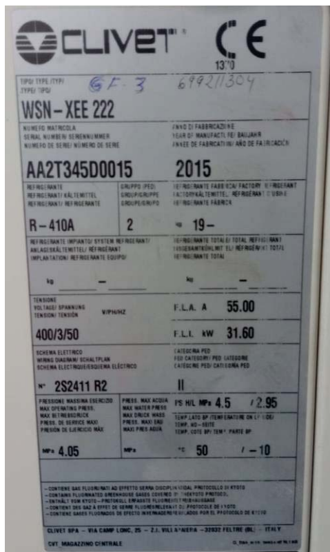
Bomba de Calor Nº 3: CLIVET modelo: WZN-XEE 222 con Nº Serie: AA2T345D0015
