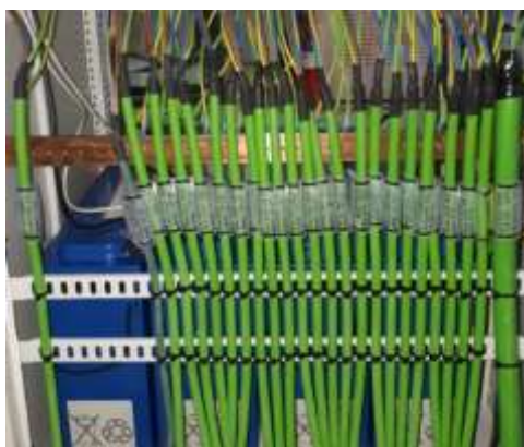
EJEMPLO DE ENTRADA DE MANGUERAS AL ARMARIO.
