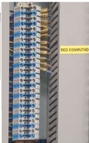
BORNAS SALIDA A EQUIPOS EN TENSION CONMUTADA
