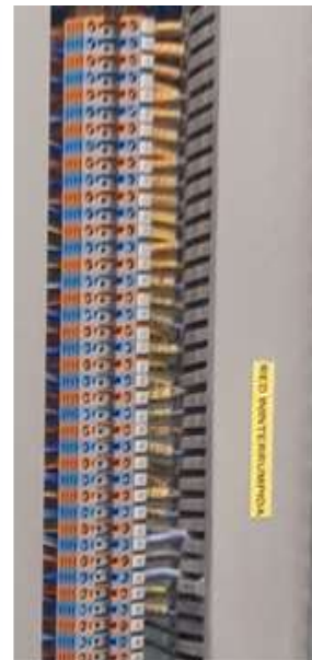
BORNAS DE SALIDA A EQUIPOS EN TENSION ININTERRUMPIDA
