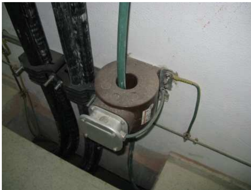
Figura 13. Toroidal protección de neutro
