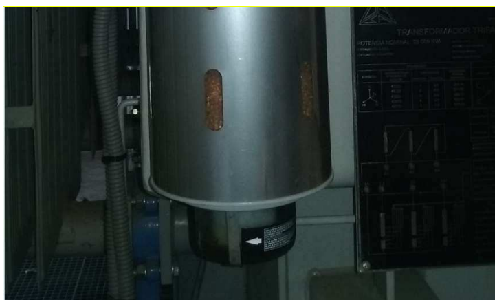
Figura 2. Deposito aceite silicagel
