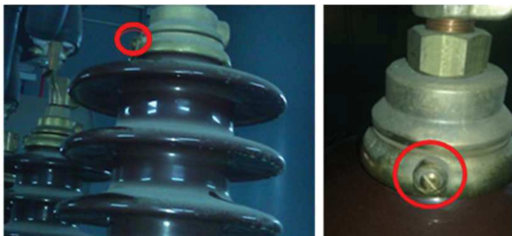
Figura 3. Purga terminales cerámicos AT / BT
