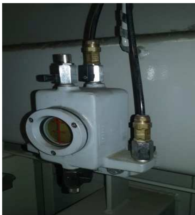
Figura 9. Recuperador / Tomador muestras relé Buchholz
