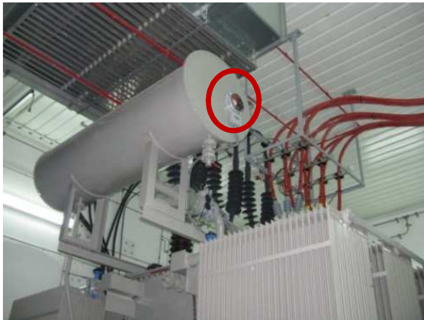
Figura 7. Nivel magnético de aceite
