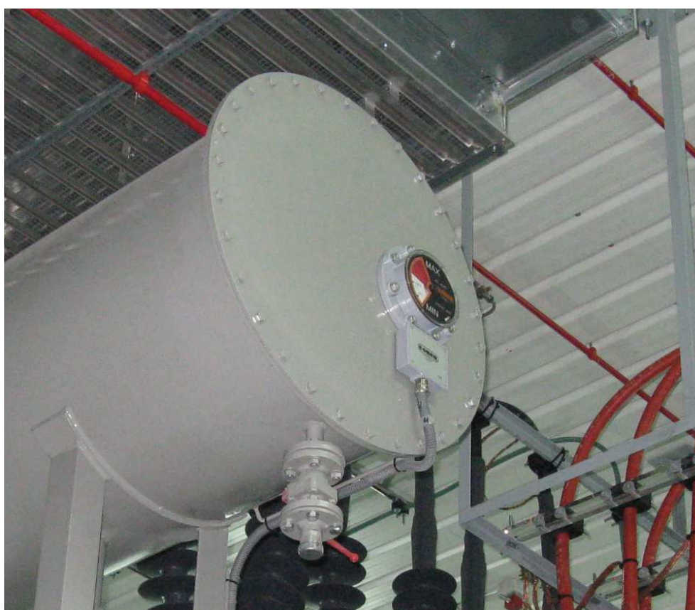
Figura 14. Nivel magnético aceite
