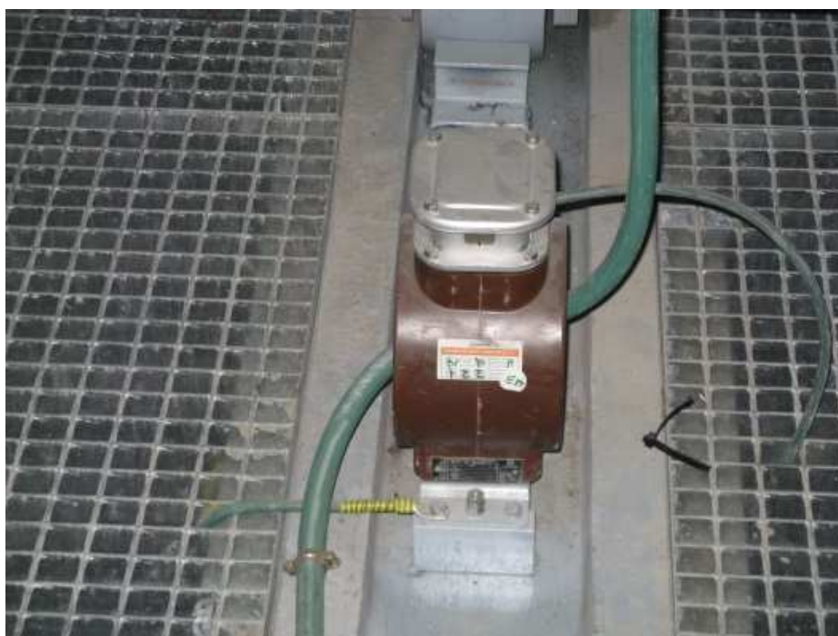
Figura 12. Toroidal protección de cuba
