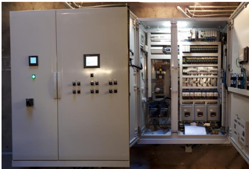
Imagen 8: Ejemplo de nuevo cuadro instalado en otro Pozos de Bombas Pluvial
