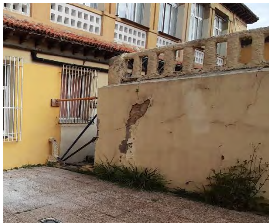
Imagen del muro de contención dañado
