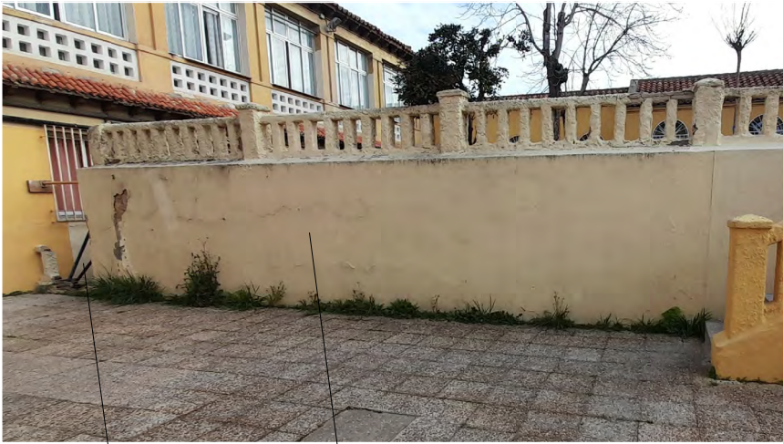
MURO DE CONTENCIÓN DAÑADO
