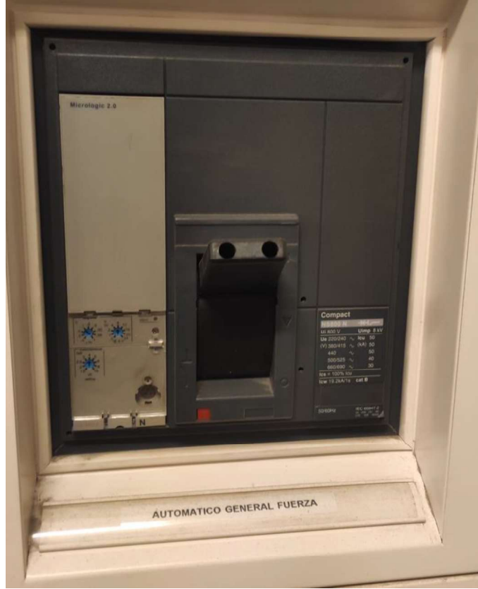
Cuadro Eléctrico Baja Tensión en Planta Sótano e Interruptor Automático General 800A
