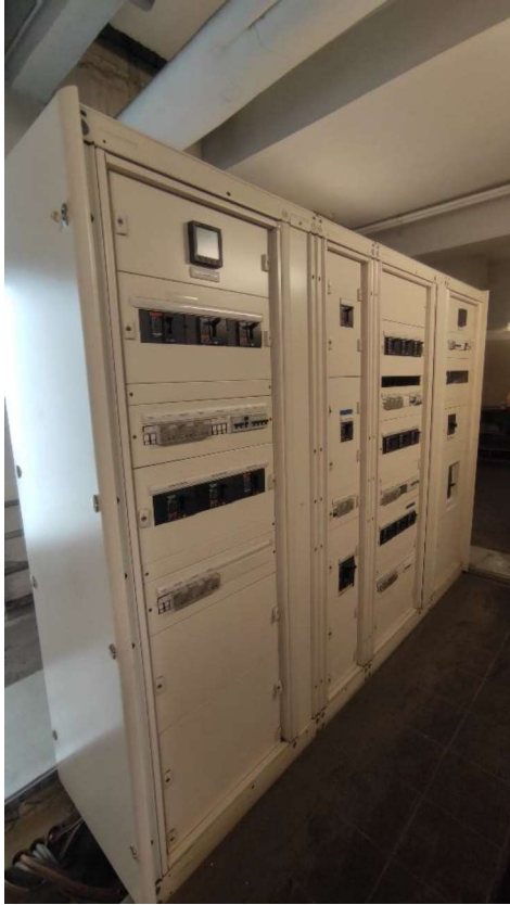
Cuadro Eléctrico Baja Tensión en Planta Sótano e Interruptor Automático General 800A
