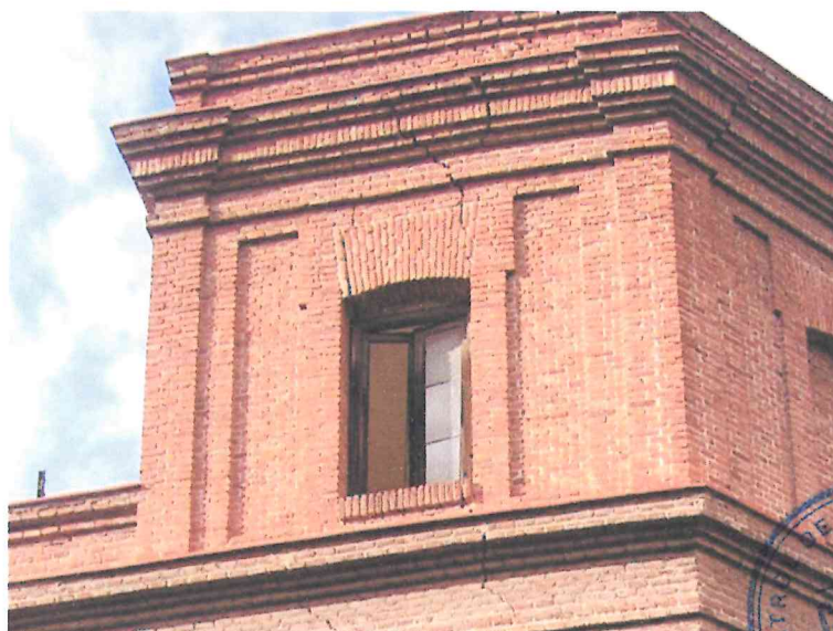
DETALLE DE FISURA EN CERRAMIENTO DE TORREON
