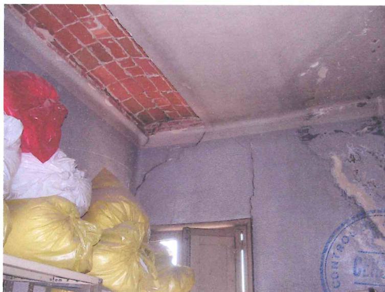
FISURAS INTERIORES CORRESPONDIENTES AL MURO EN PLANTA PRIMERA
