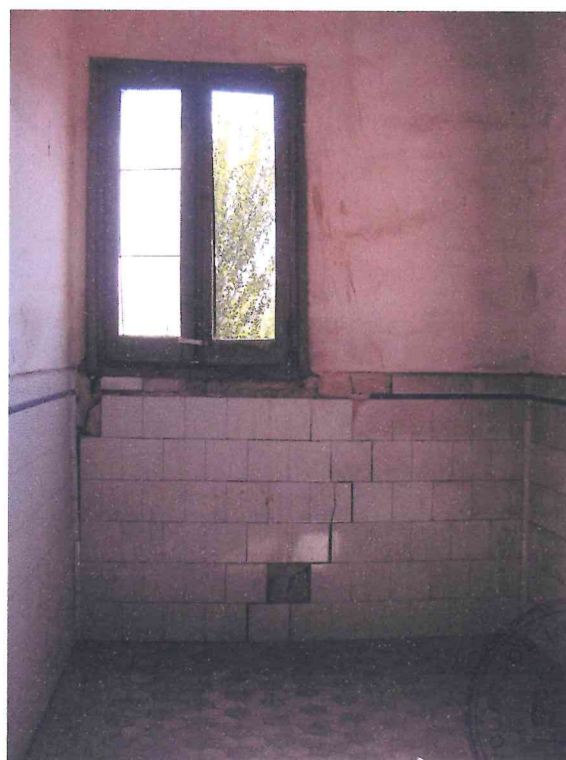
FISURAS CORRESPONDIENTES AL INTERIOR DEL TORREON. APRECIESE EL DESCUADRE DE LA VENTANA Y LA INCLINACIÓN DEL FORJADO
