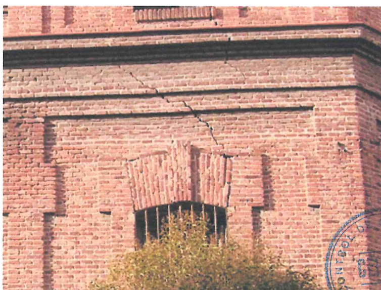
DETALLE DE FISURA EN CERRAMIENTO DE PLANTA PRIMERA
