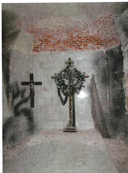
Aspectos del interior del templo desde el nivel del coro, y detalles de las vidrieras de Maumejan. Vista del estado actual de la sepultura en la cripta en la que se aprecia pérdida de revoco en la bóveda y pintadas en el azulejado.
