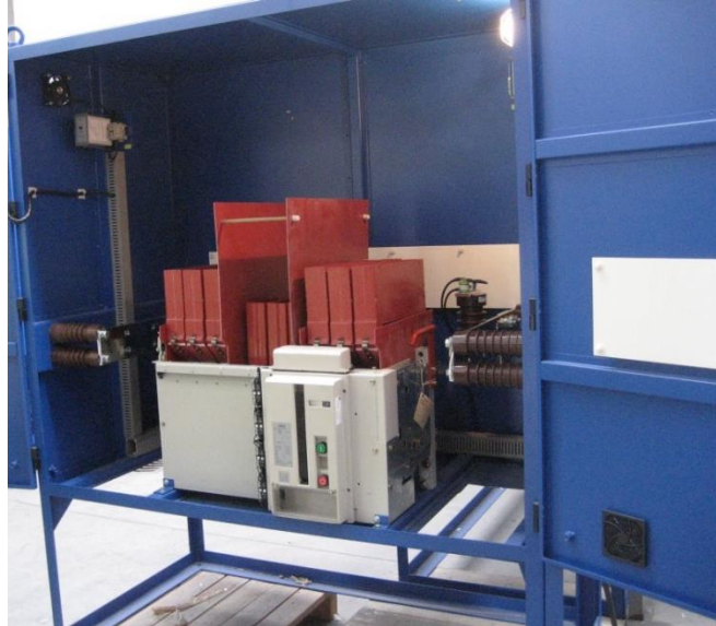
Figura 2: armario seccionador
