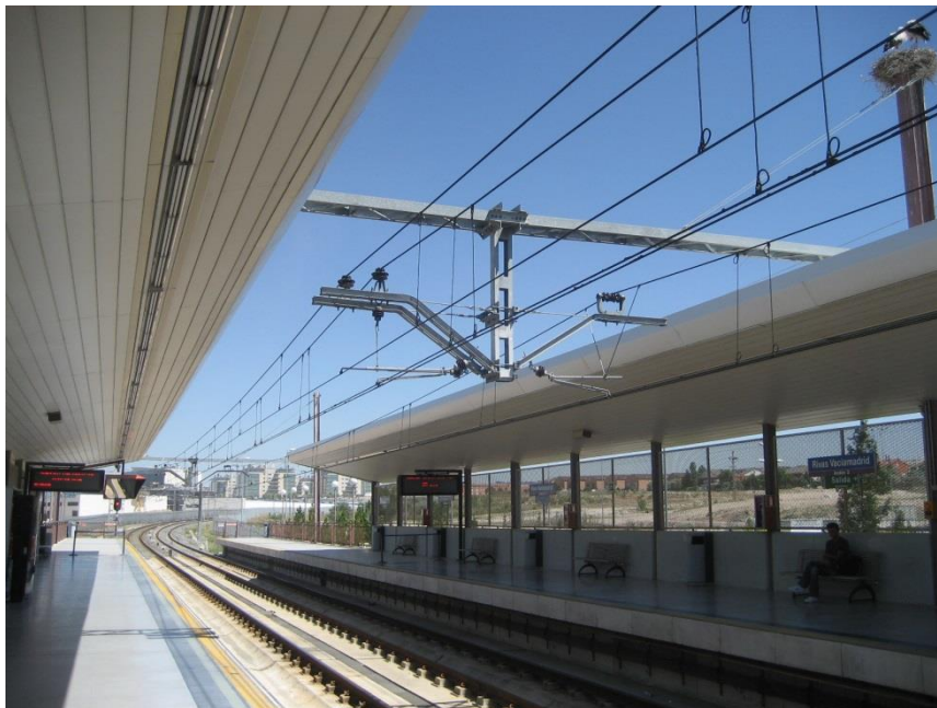
Figura 4: Estación de Línea 9 con catenaria convencional
