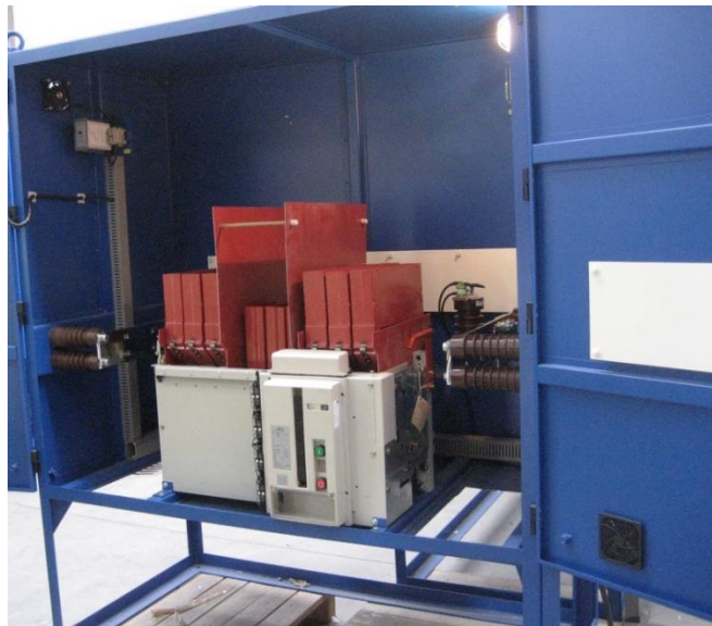
Figura 2: armario seccionador
