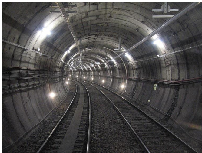
Figura 5: imagen de túnel electrificado con catenaria rígida.
