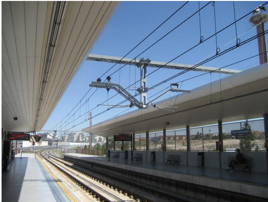
Figura 4: Estación de Línea 9 con catenaria convencional
