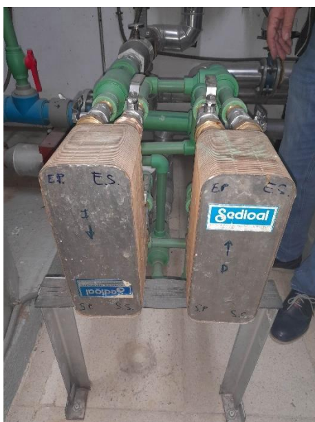
Intercambiador Primario ACS
