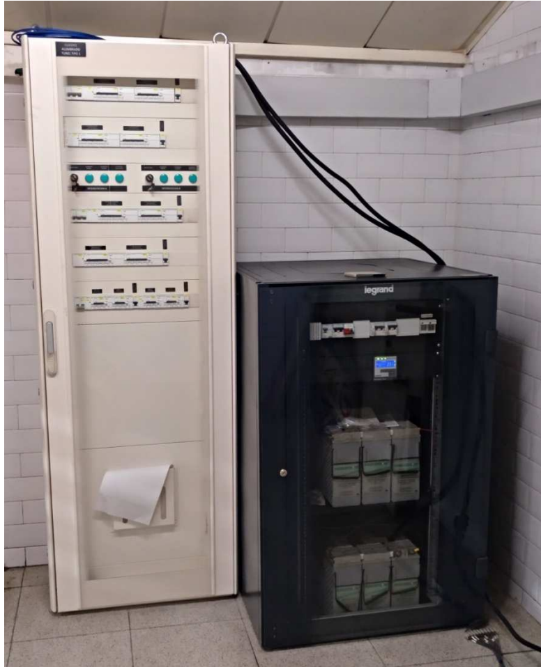
Cuadros de alumbrado y SAI de túnel.
