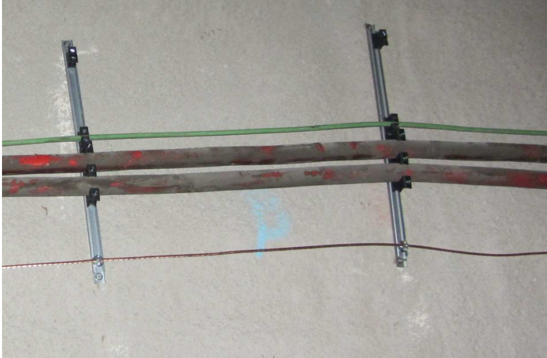
Conexión a tierra tipo soportes túnel
