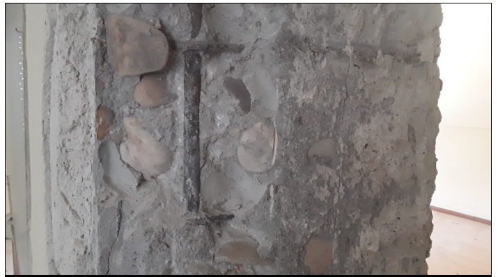
4. CP4. Detalle de armaduras
