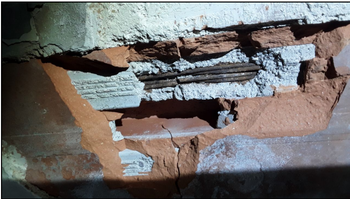
5. Armaduras lisas en vigueta diámetro 3,85mm con corrosión y rotura de armaduras
