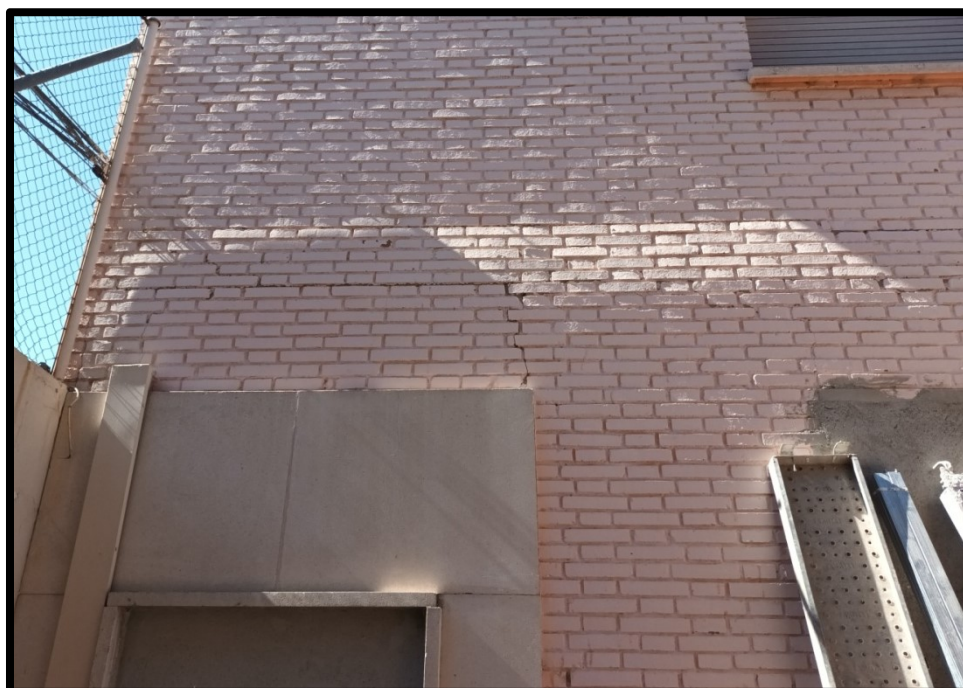
Vista del desplome de fachada norte calle sierra de Palomeras
