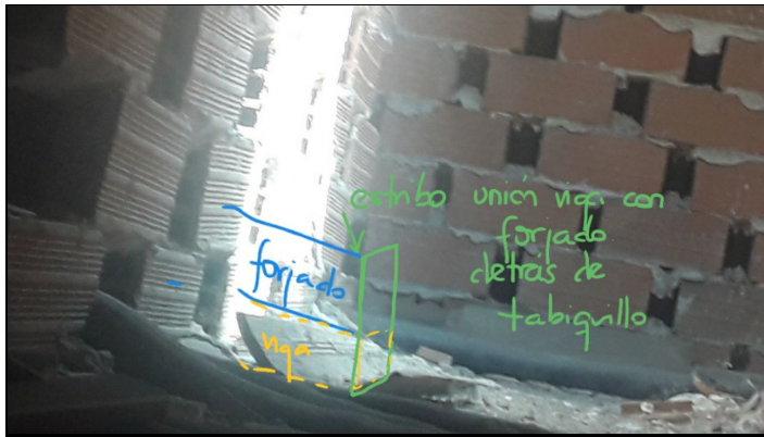
8. CF6. Detalle d estribo unión viga y forjado
