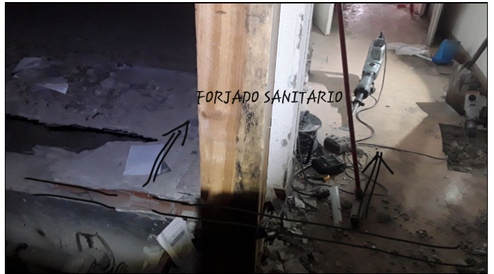
6. Forjado sanitario a partir de muro de carga
