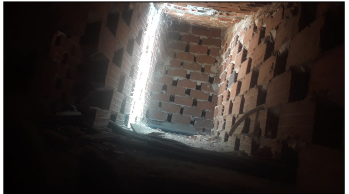
6. Vista general mediante trampilla de acceso a bajo cubierta. Cubierta soportada por tabiquillos
