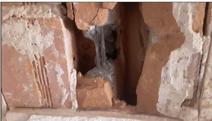
3. CF6. Detalle armadura inferior de vigueta 4D3,5x2
