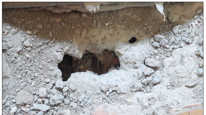
4. CF5. Localización de armado superior de vigüeta 1D4. No se encuentran negativos de forjado
