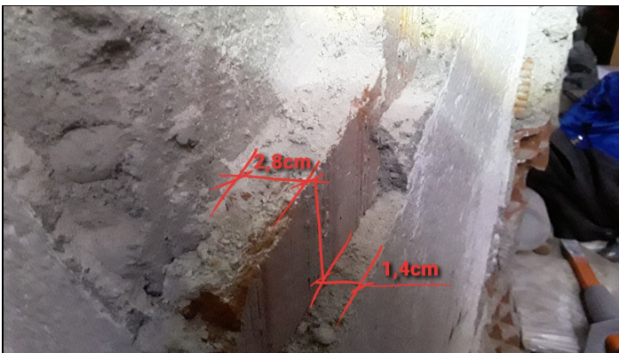
3. CP1. Detalle de capas de revestimiento
