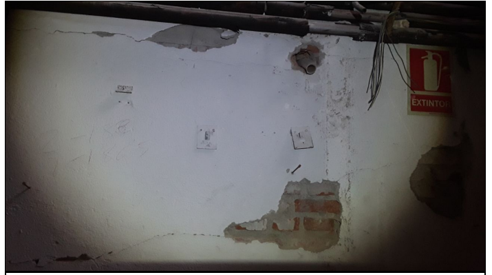
2. Grietas pasantes en toda la longitud del muro de carga altura aprox. 1,15m y 1,90m desde suelo
