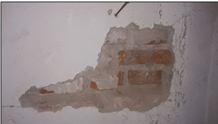
5. CM2. Cata muro cara norte. A 1,15m del suelo. 45x30cm. Revoco 5mm. A 4m de muro fachada Este
