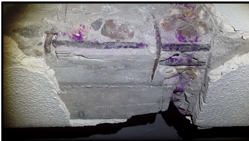
Detalle de armaduras de viga techo de planta baja
