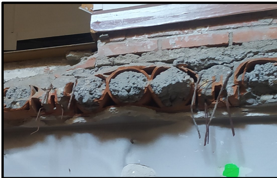
Detalle de forjado de sección del forjado tras el derrumbe
