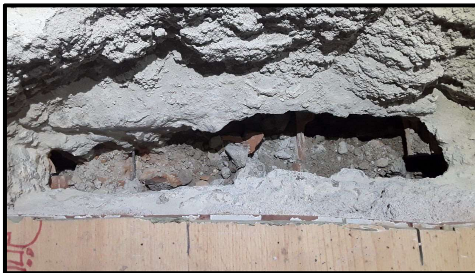
Detalle de cata de forjado donde se muestra la ausencia de armaduras superiores
