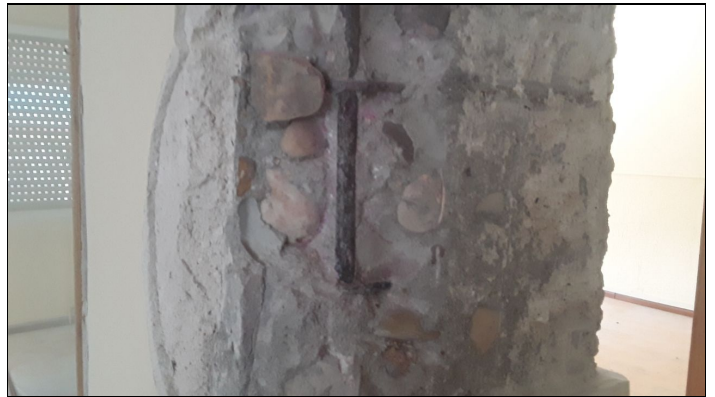
6. CP4. ensayo fenolftaleína. Hormigón carbonatado
