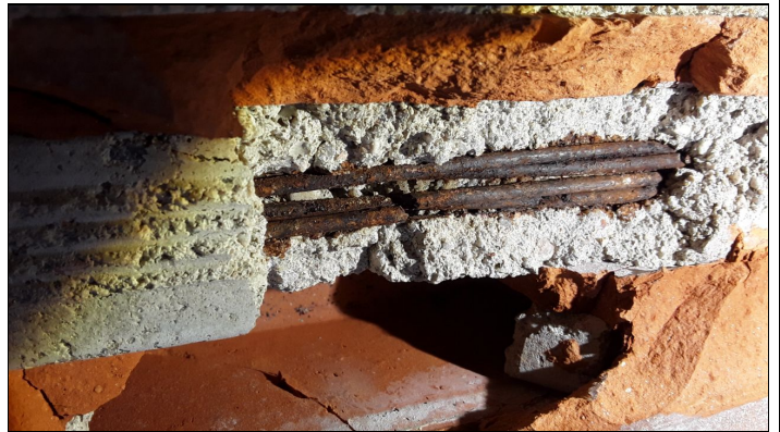
6. Ensayo fenolftaleína. Hormigón carbonatado
