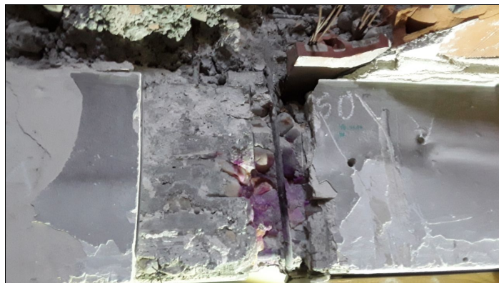
8. CV2. Estribo atado de viga y forjado.
