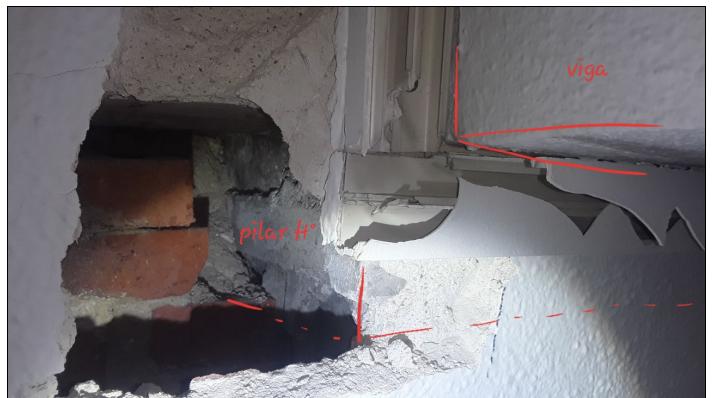
4. CM4. Viga apoya en pilar
