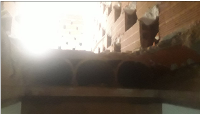
5. CF6. Detalle d bovedilla
