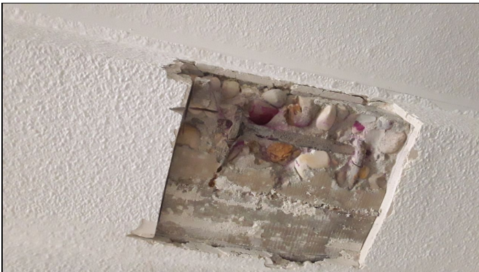
3. Ensayo de fenolftaleína. Hormigón carbonatado
