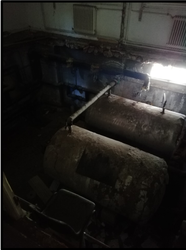
Zona afectada. Forjado techo sotano zona sala de calderas Este desprendido
