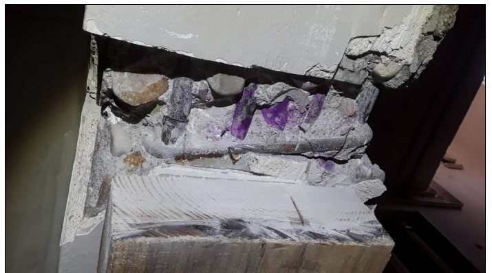
4. CV2. Cata viga 1. Armadura inferior 4D17.
