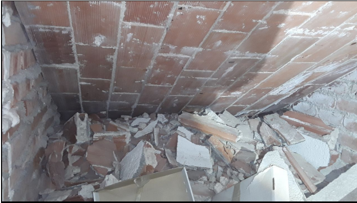
1.Losa de escalera en planta baja. Sin apoyo en tabiques
