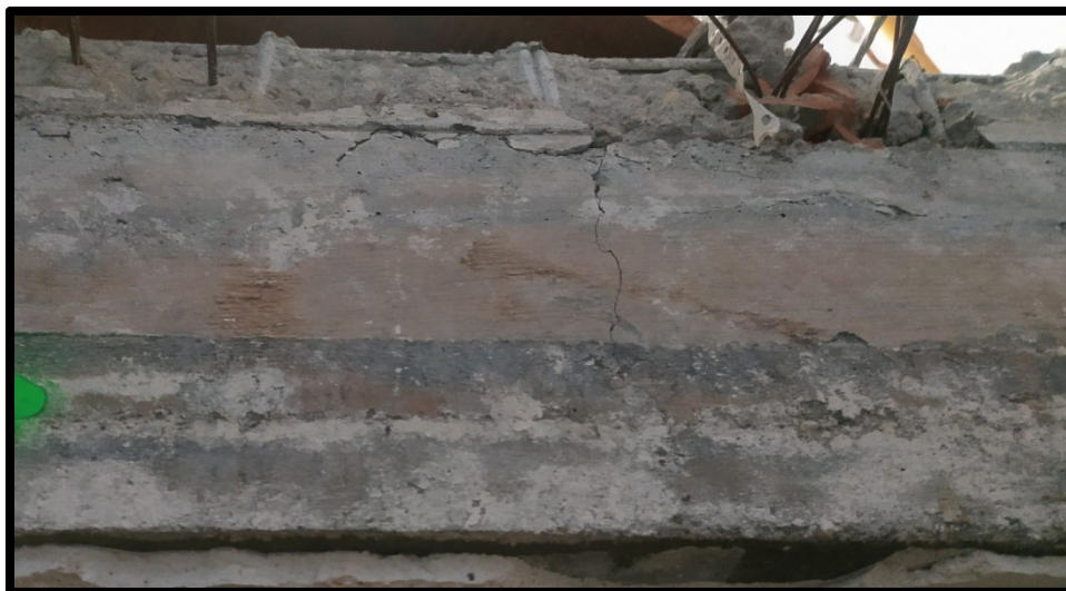
Detalle de fisura en viga de techo de planta sótano
