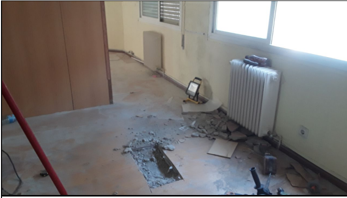
1. Vista general cata forjado suelo de planta primera CF5
