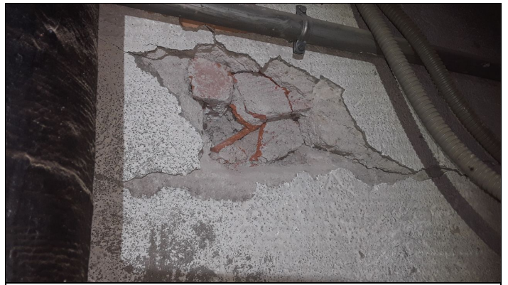
8. CM3. Cata 20x30cm a 1,5m del suelo. Revestimiento 3cm
