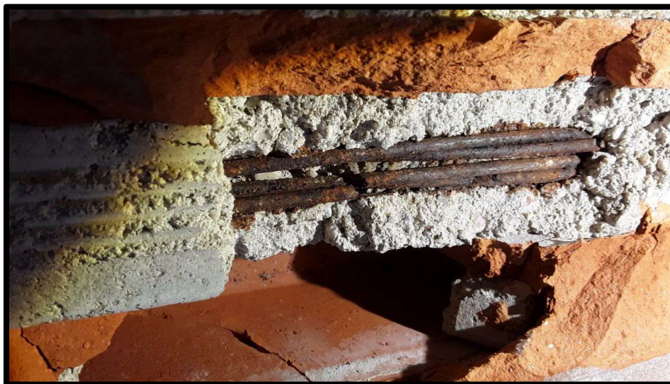
Detalle de armaduras de vigueta cerámica forjado techo de sótano
