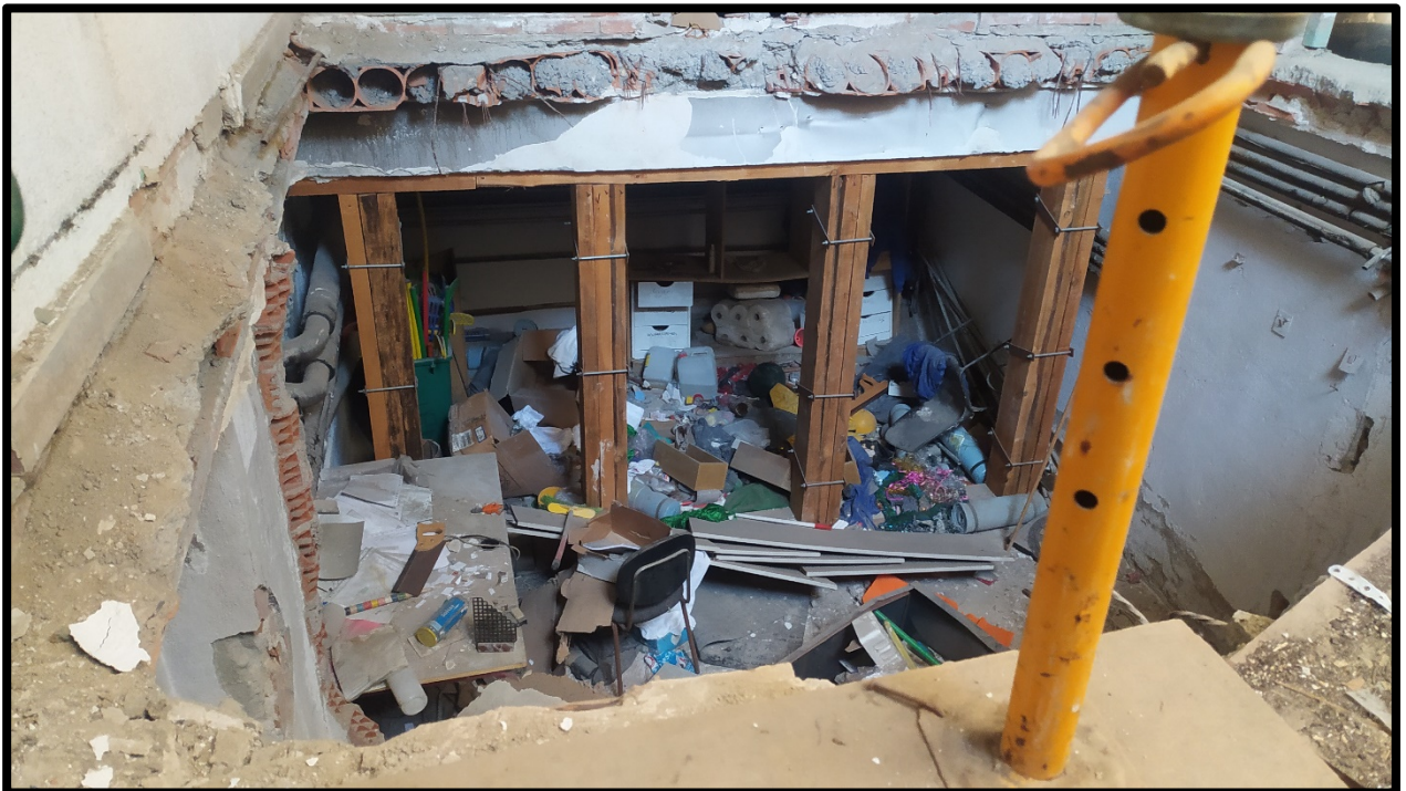
Zona afectada. Forjado techo sotano zona sala de calderas Este desprendido
