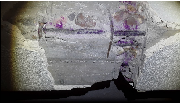
5. CV3. Detalle de cata. Dimensiones cara sur 40x30cm. Cara inferior 35x35cm.
