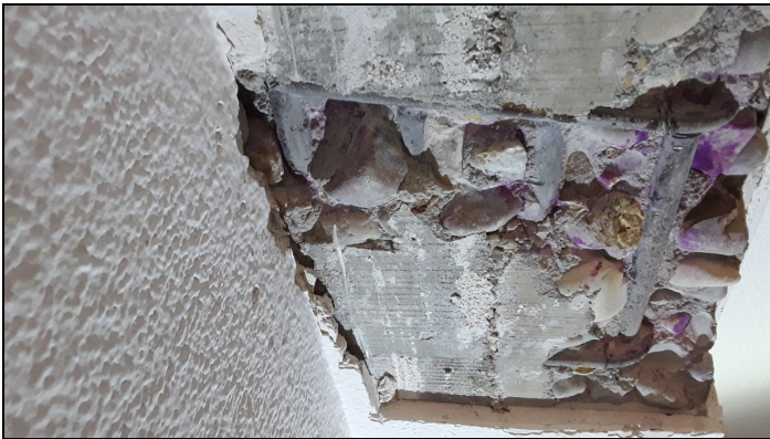
5. CV4. Armaduras 4D18c/67 e10c/20
