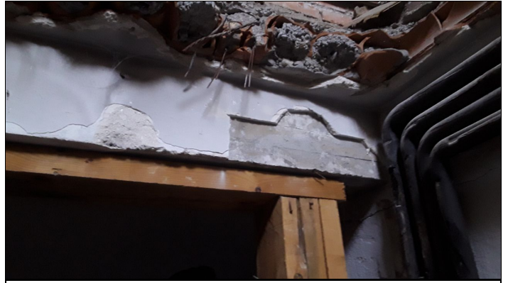
2. CV1. Cata viga 1. Tablones de madera debajo d revestimiento lateral oeste de espesor 5cm
