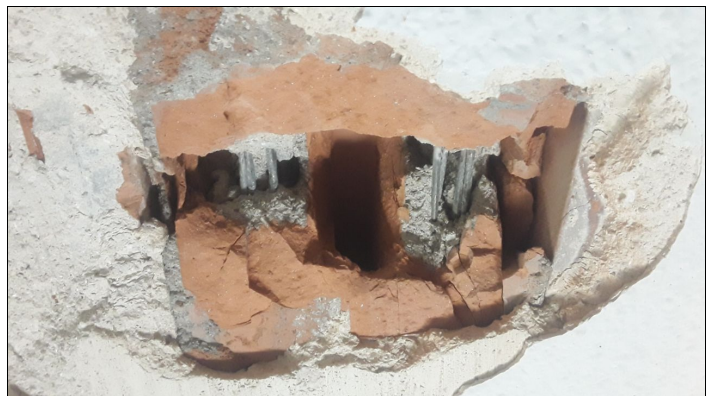
4. Armadura d vigueta 4D3.
