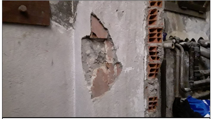
2. Detalle capas. Revestimiento, ladrillo, mortero, hormigon
