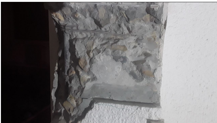
3. CP2. Armadura longitudinal 4D18,5 liso. e7 c/14 armadura helicoidal
