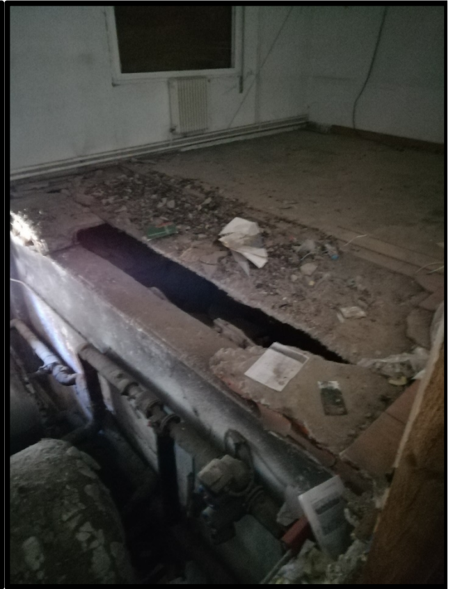
Zona afectada. Forjado techo sotano zona sala de calderas Este desprendido
