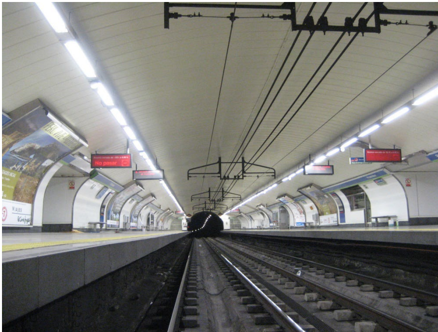
Figura 3: imagen de una estación con hilo tranviario.
