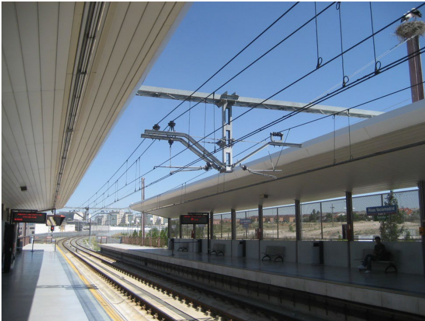
Figura 4: Estación de Línea 9 con catenaria convencional
