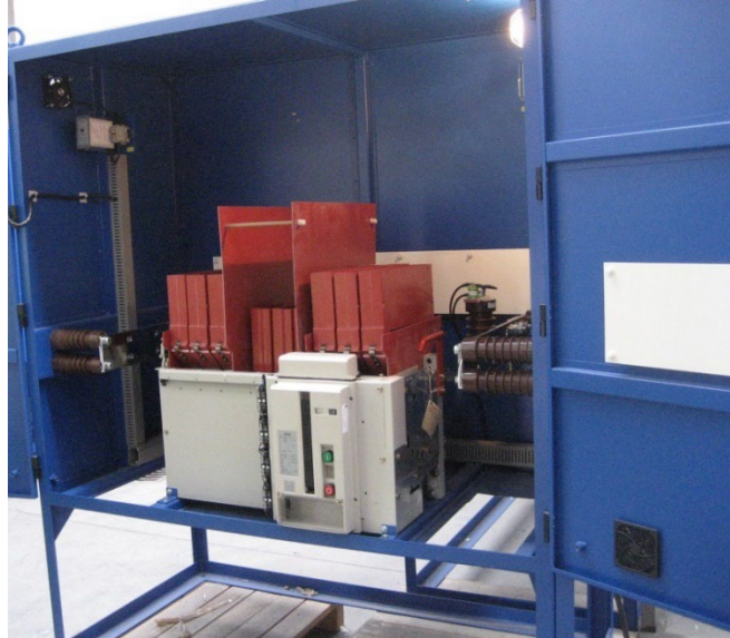
Figura 2: armario seccionador
