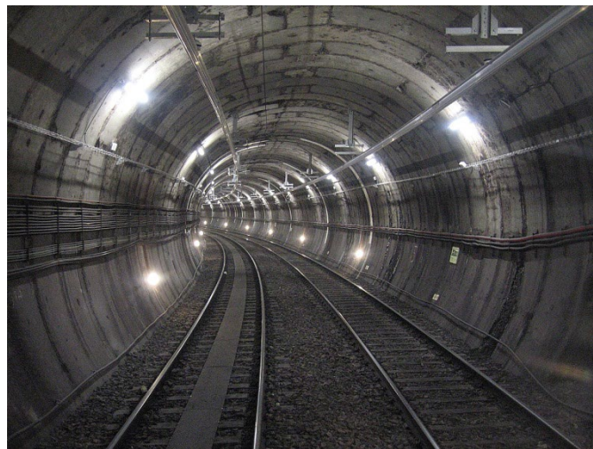
Figura 5: imagen de túnel electrificado con catenaria rígida.
