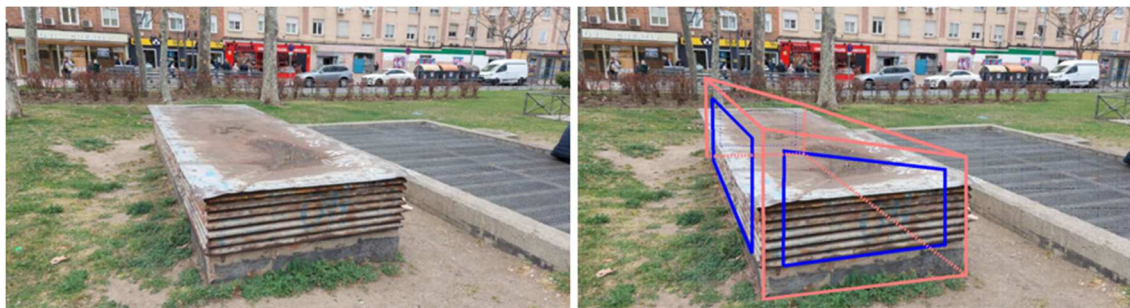
Figura 9: Estado reformado de la rejilla del pozo de inmisión
