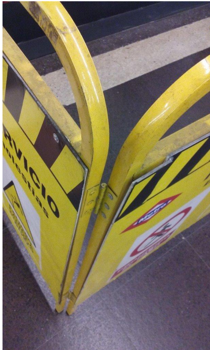
Detalle de las bisagras de unión entre paneles
