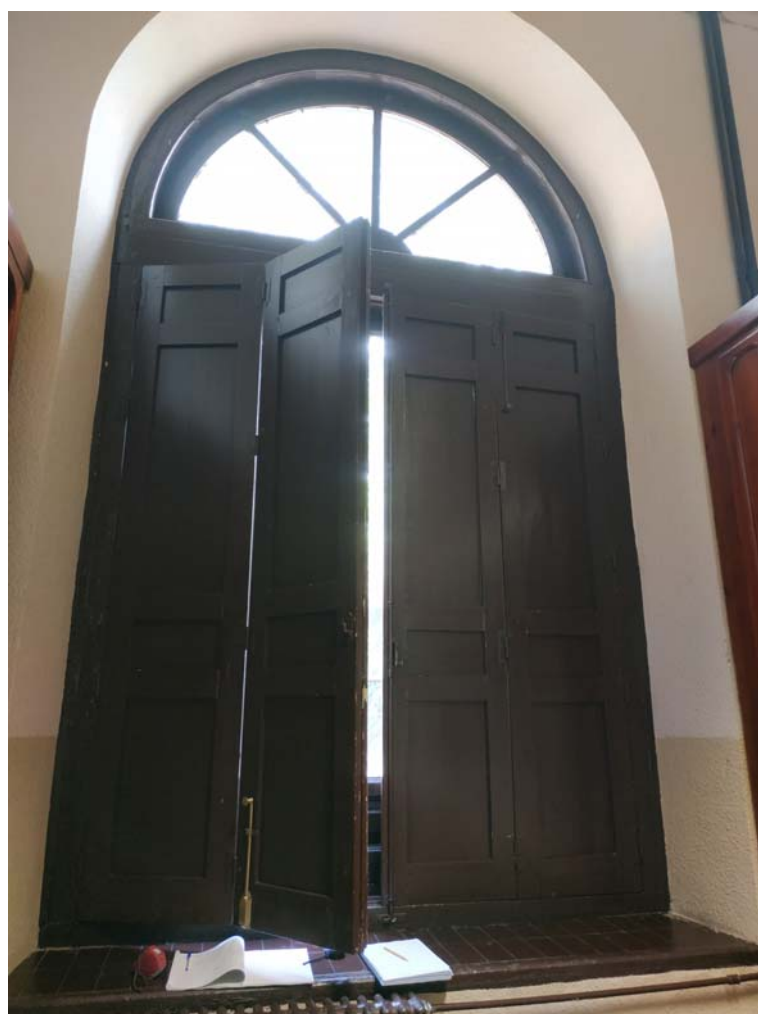
HUECOS CON VENTANA Y CONTRAVENTANA DE CARPINTERÍA DE MADERA HACIA EL PATIO INTERIOR DE JUEGOS
