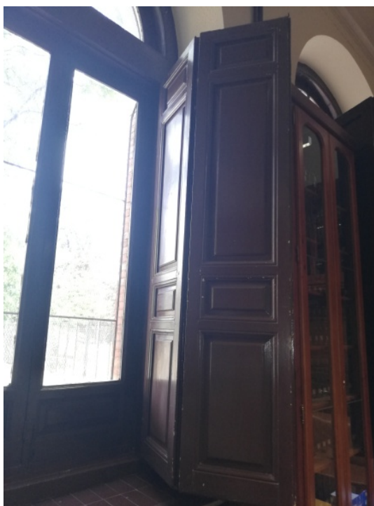
Fotos de las ventanas que dan sobre el patio de juegos. Estos huecos disponen de contraventanas de madera con cuerpos dobles abatibles. Hay una malla metálica de alambre tipo tela de gallinero como protección contra los balonazos.
