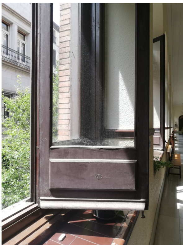
DETALLES DE VENTANA CON CARPINTERÍA DE MADERA Y VIDRIO SENCILLO
