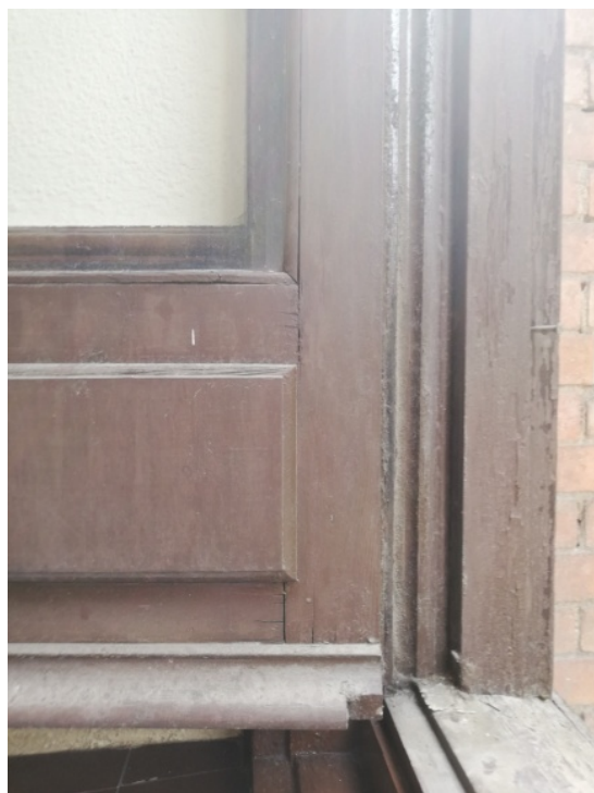
Imágenes del vierteaguas de chapa de zinc y del marco de madera con restos de pintura desprendidos por falta de mantenimiento
