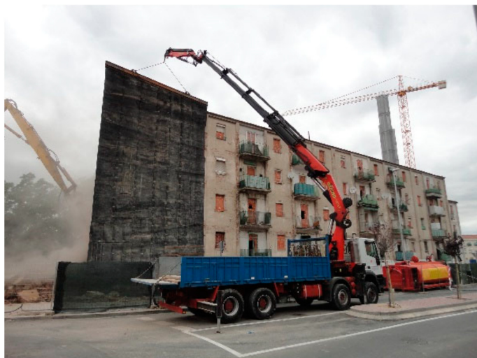
foto_09. Pantalla de protección suspendida por grúa autopropulsada
