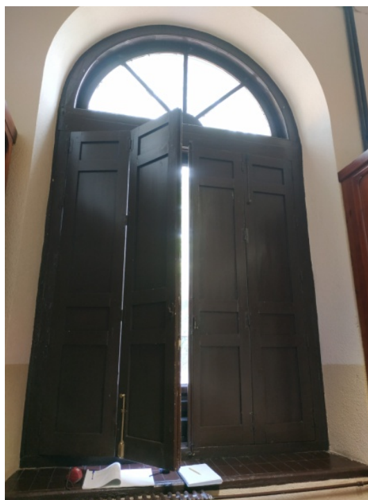
Fotos de las ventanas que dan sobre el patio de juegos. Estos huecos disponen de contraventanas de madera con cuerpos dobles abatibles. Hay una malla metálica de alambre tipo tela de gallinero como protección contra los balonazos.
