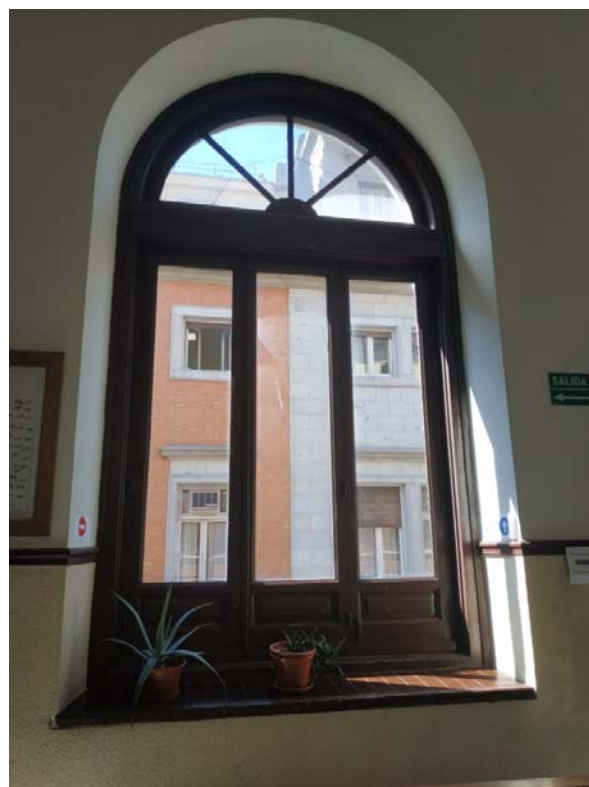
DETALLES DE VENTANA CON CARPINTERÍA DE MADERA Y VIDRIO SENCILLO
