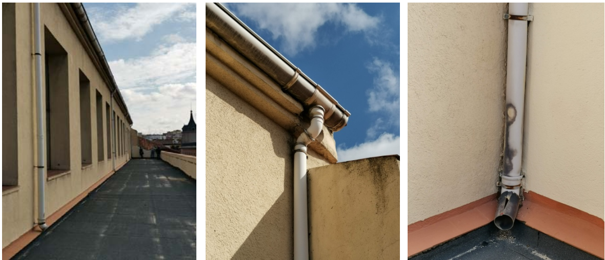
Vista de terraza de planta primera con las bajantes de un tramo en mal estado y el canalón lineal bajo el alero
