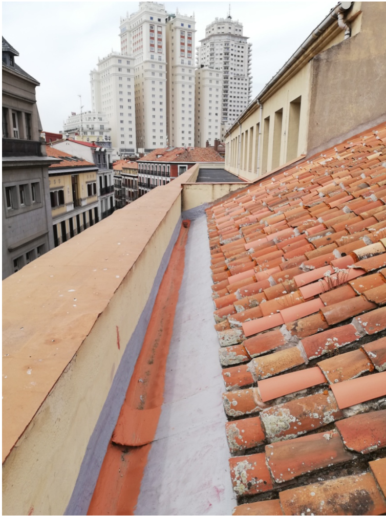
DETALLES DE LA CUBIERTA SOBRE EL VESTÍBULO PRINCIPAL DE ENTRADA Y SUMIDERO
