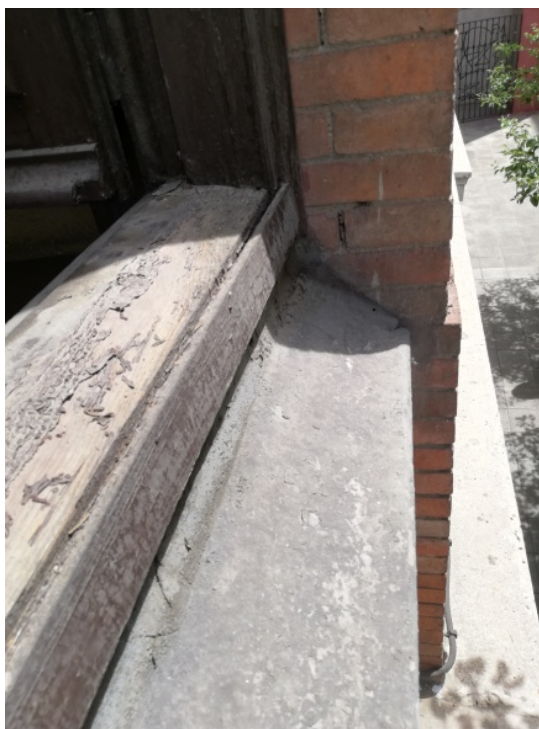
Imágenes del vierteaguas de chapa de zinc y del marco de madera con restos de pintura desprendidos por falta de mantenimiento
