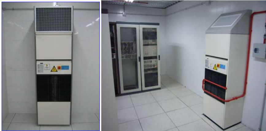
Figura 16 - Equipos de refrigeración en cuartos técnicos
