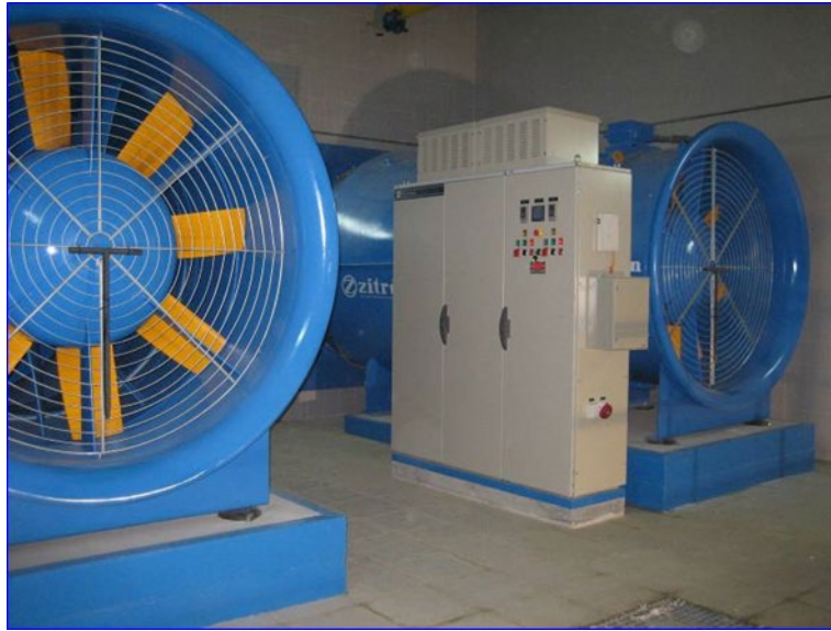
Figura 4 Ventiladores instalados en túneles de interestación
