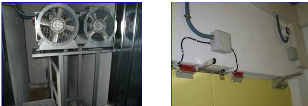
Figura 14 Ventiladores de extracción y elementos de control del sistema de presurización en salida de emergencia
