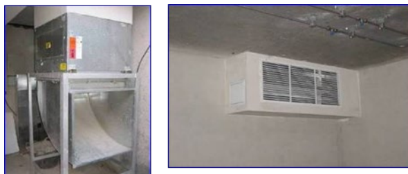
Figura 11 Conducto y compuertas de extracción de humos
