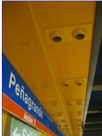
Figura 7 Toberas de ventilación en estación
