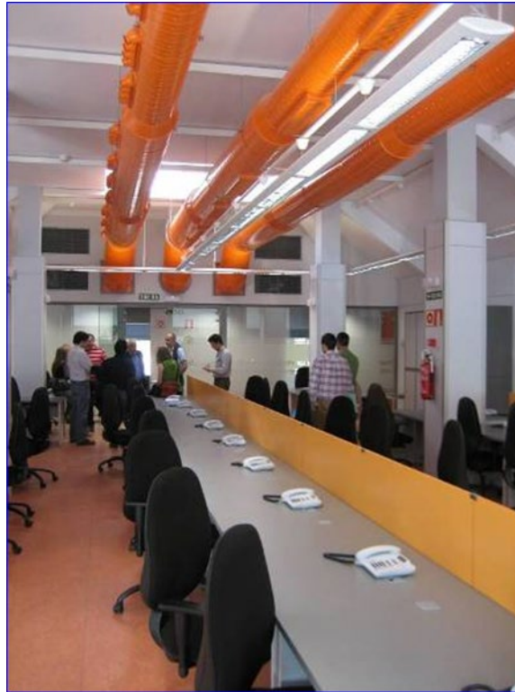
Figura 8 Distribución de conductos de ventilación
