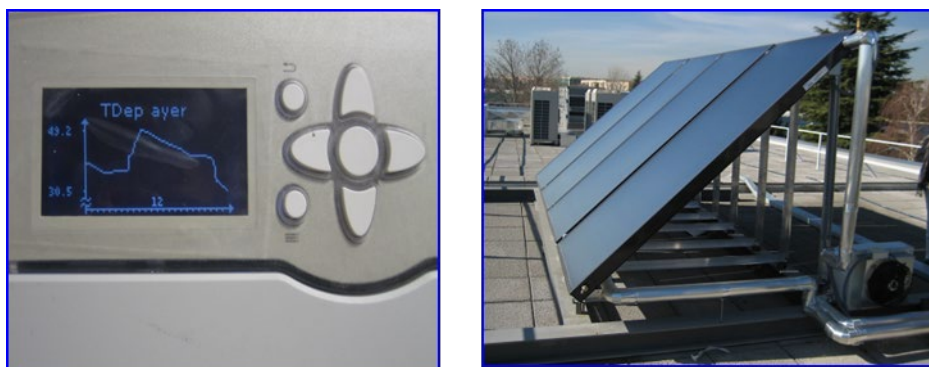
Figura 19 Placas solares térmicas y visualización de control
