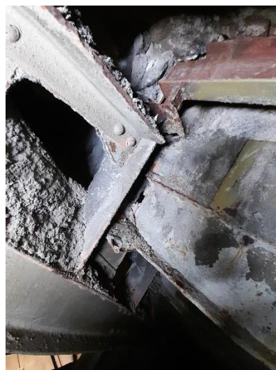
Nudo de apoyo de gradas deformado.
