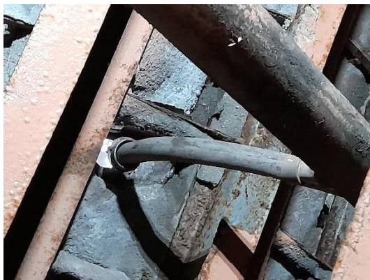
Ausencia de cazoleta en desagüe.
