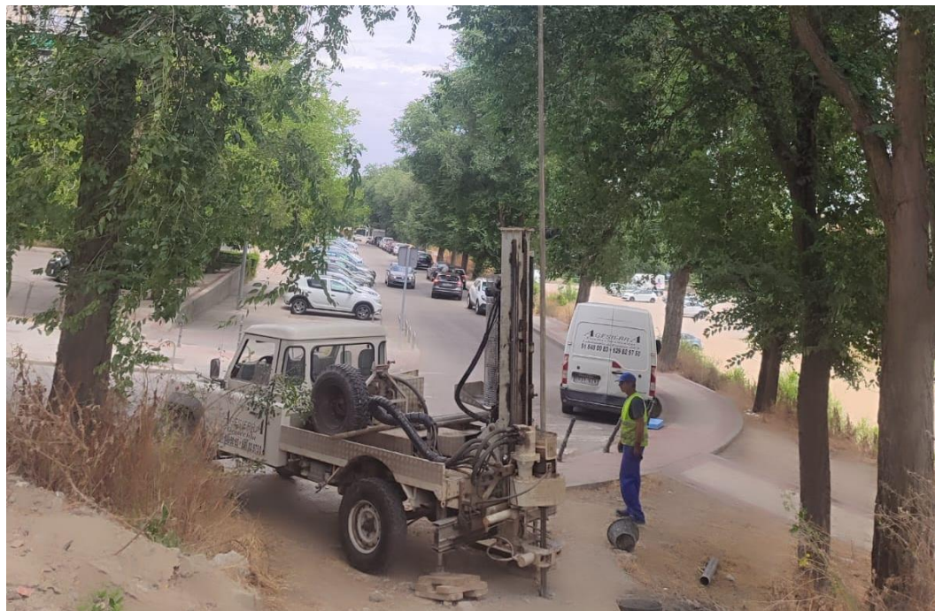
Figura Nº 1.- Imagen de la ejecución del sondeo mecánico y rotativo con extracción continua de testigo referido como S-01.
