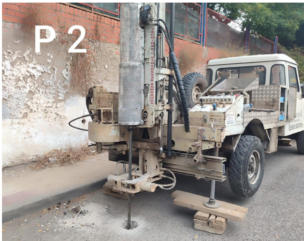
Figura Nº 2.- Trabajos para la realización de la penetración dinámica, tipo DPSH, referida como P-02.
